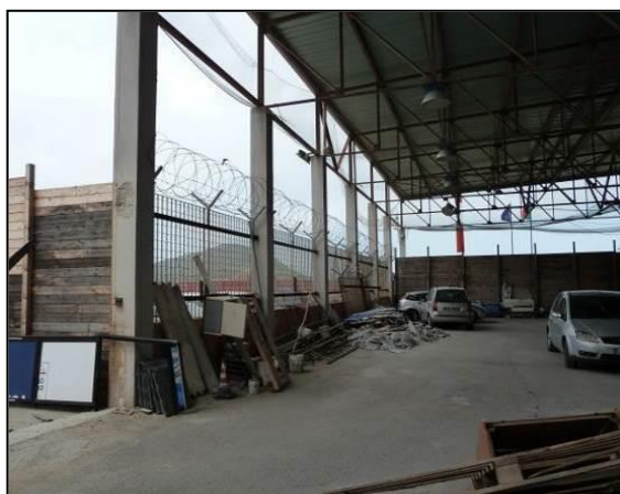
Foto 5, 6, 7, 8: la struttura di copertura, si noti il degrado degli elementi metallici
