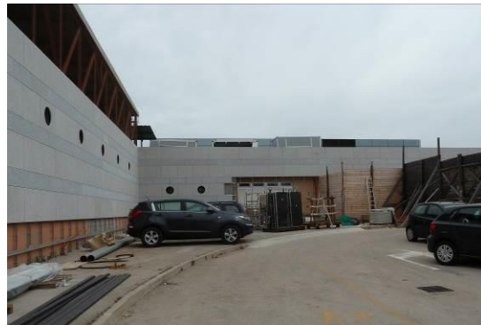
Foto 1, 2: la struttura esistente dal lato terra, si noti il rivestimento parzialmente realizzato
