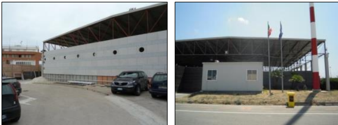
Foto 1, 2: la zona di intervento rispettivamente dal lato terra e dal lato aria
