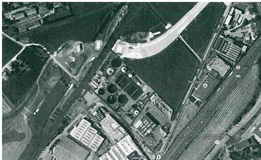
Figura 2. Impianto di depurazione di Montecchio Maggiore, gestito da Acque del Chiampo S.p.A..
