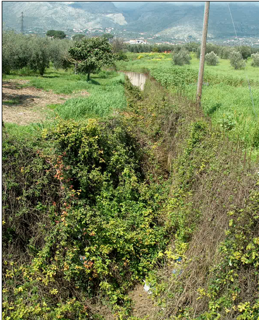
Immagine dell'alveo a monte dell'intervento in progetto
