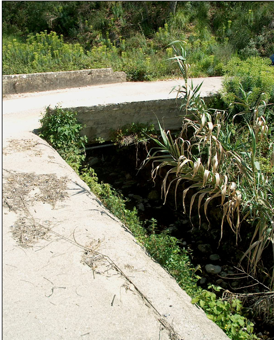
Foto che mostra il ponte esistente guardando verso monte
