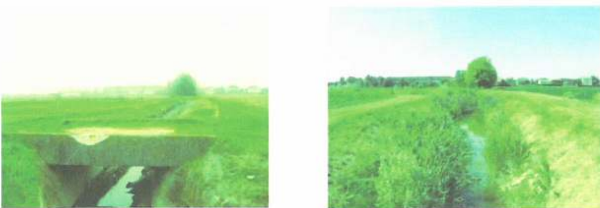
Figura 9: un canale di scolo di modeste dimensioni prima e dopo un intervento di manutenzione straordinaria con il quale è stato eliminato il rivestimento di calcestruzzo, permettendo il miglioramento delle condizioni ambientali del corso d'acqua. (Fonte: Consorzio di Bonifica Acque Risorgive, risorsa online)
