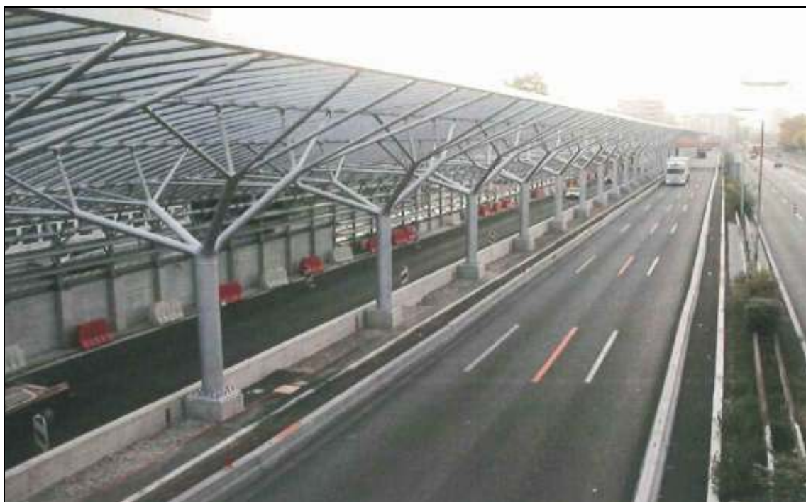
STRUTTURA PORTANTE IN CARPENTERIA METALLICA SNODI IN FUSIONE DI ACCIAIO RIFERIMENTO NORMATIVA EN 1794-1
