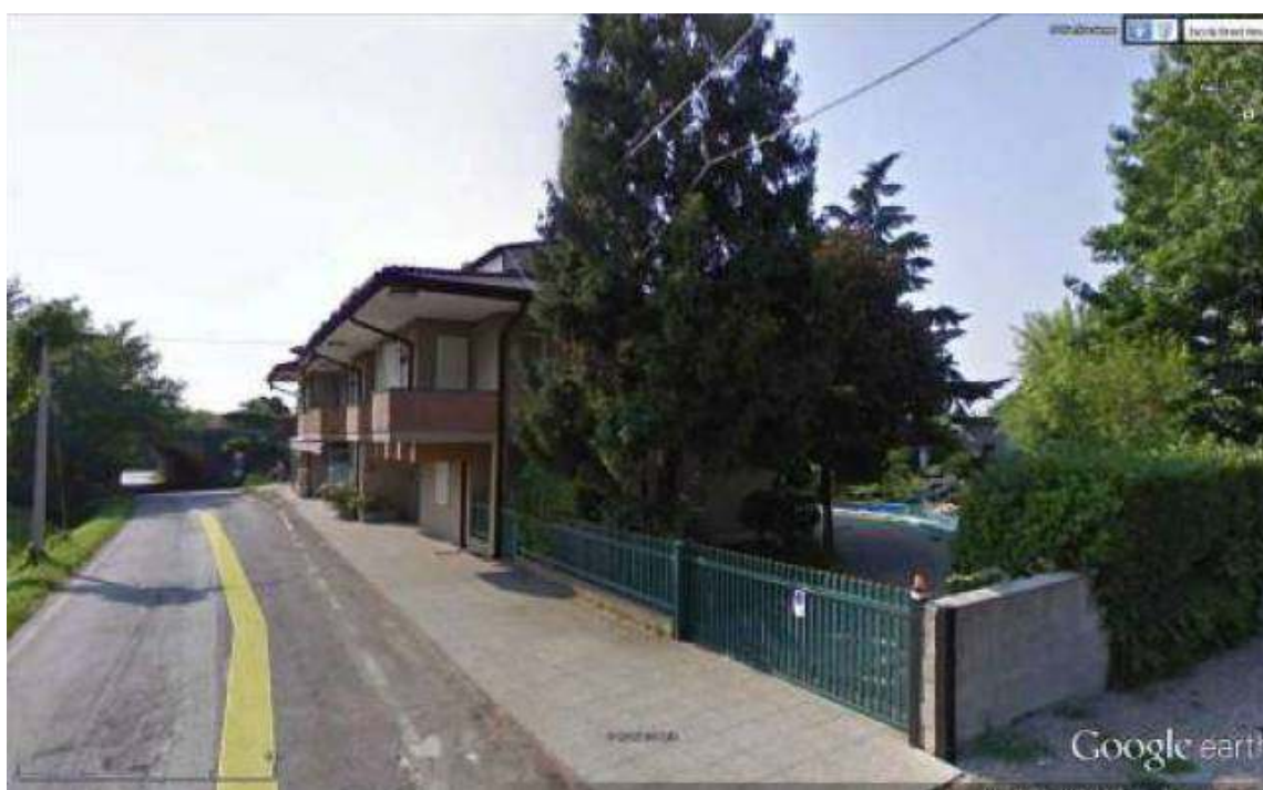
Figura 53: Localizzazione e foto edifici interessati dal tracciato in loc. Locara (su ortofoto Google Earth)
