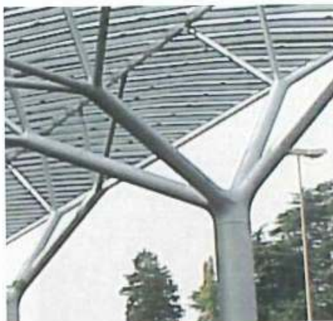
STRUTTURA PORTANTE IN CARPENTERIA METALLICA SNODI IN FUSIONE DI ACCIAIO RIFERIMENTO NORMATIVA EN 1794-1
