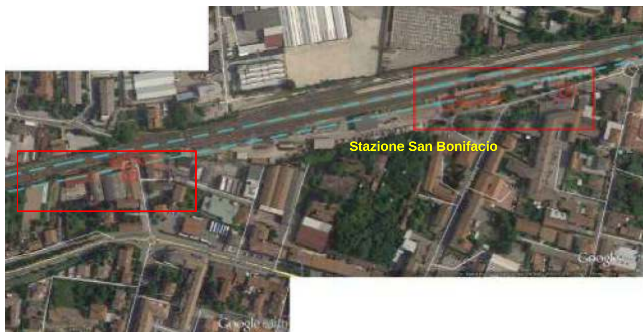
Figura 43: Vista generale degli edifici interferiti in centro
