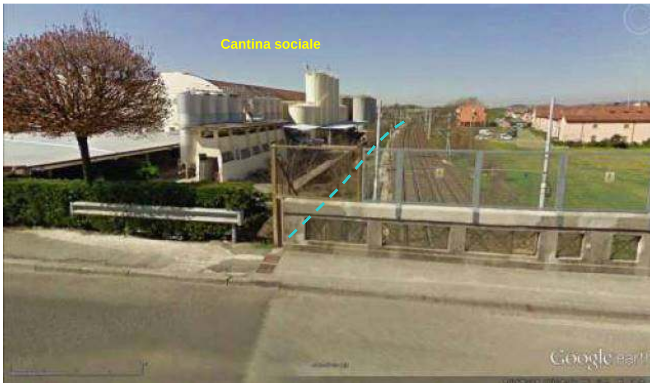
Figura 38: Cantina sociale di San Bonifacio (su ortofoto Google Earth)
