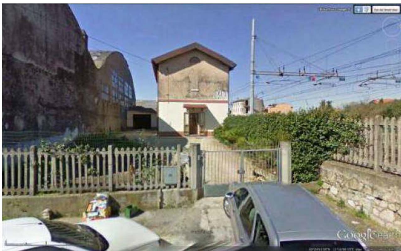
Figura 44: Edificio residenziale e produttivo da demolire in via Minghetti Bonifacio (su ortofoto Google Earth)
