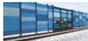
Pannelli a cassetta in alluminio e pannello interno in lana minerale Altezza = 4 metri Lunghezza tratta = 560 m
