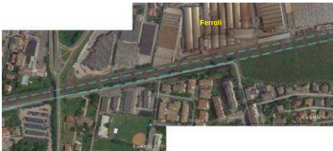
Figura 50: Vista generale zona Praissola e immissione in aperta campagna (su ortofoto Google Earth)
