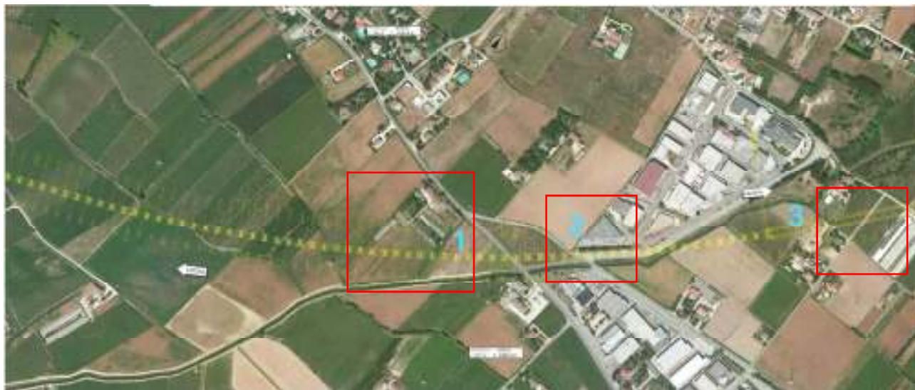
Figura 22: Tratto successivo alla fine della Porcilana esistente "VARIANTE SUD"
