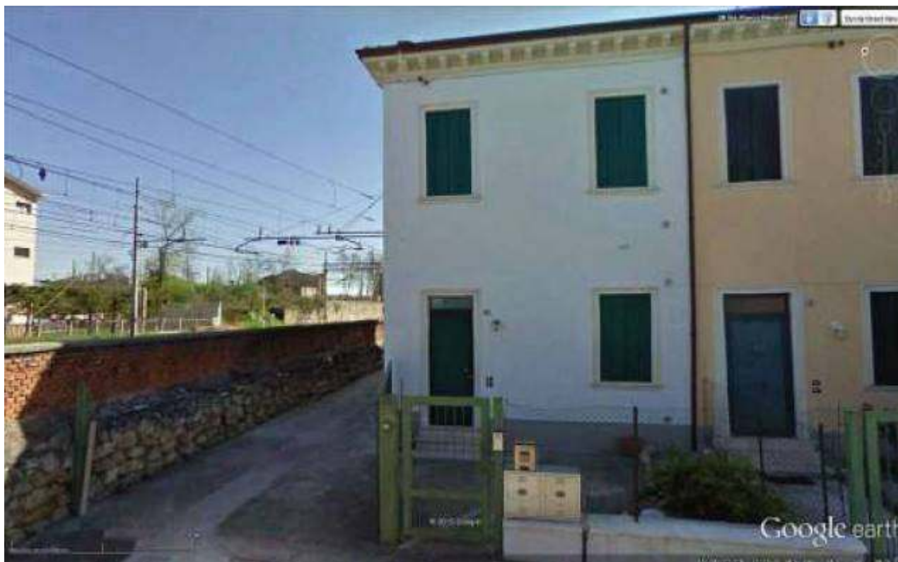
Figura 45: Edificio residenziale da demolire in via Minghetti (su ortofoto Google Earth)
