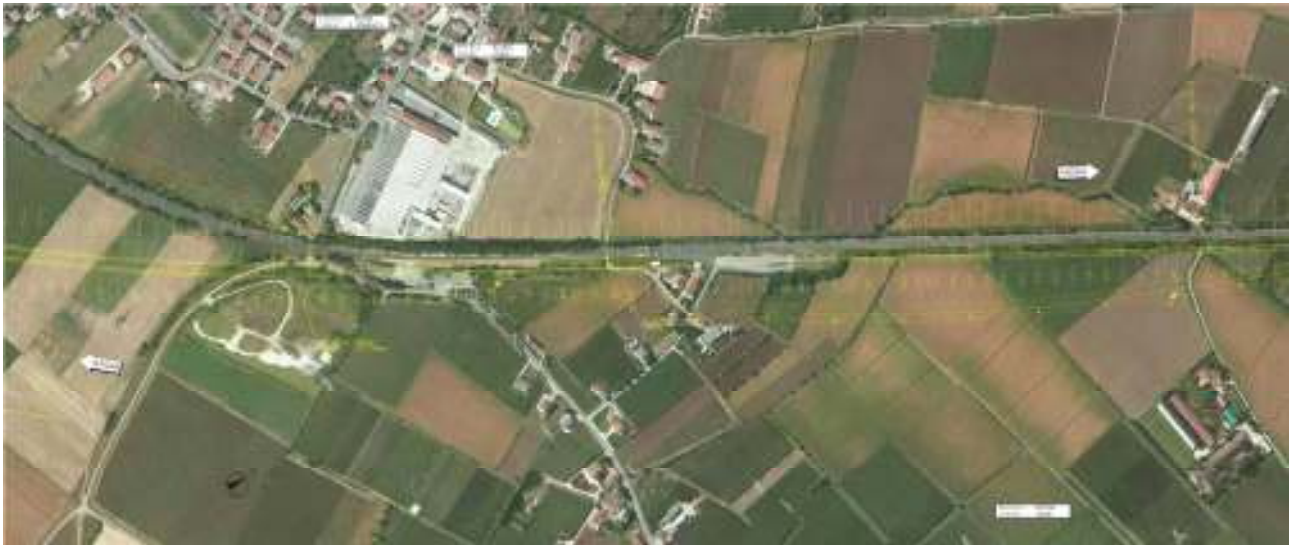
Figura 31: Tratto in loc. Locara “VARIANTE SUD”
