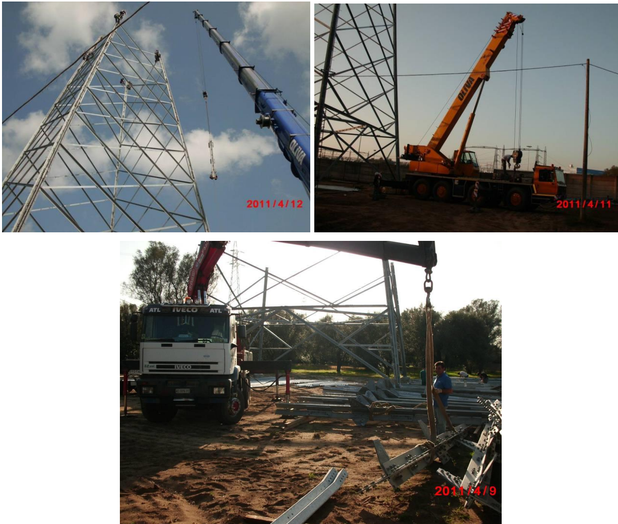
Figura 2.2.3-1 – Fasi di montaggio di un sostegno
