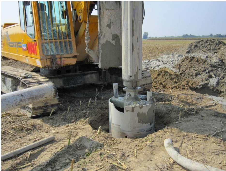
Figura 2.2.2-7 – Macchina operatrice per la realizzazione di pali trivellati. Particolare del “carotiere”
