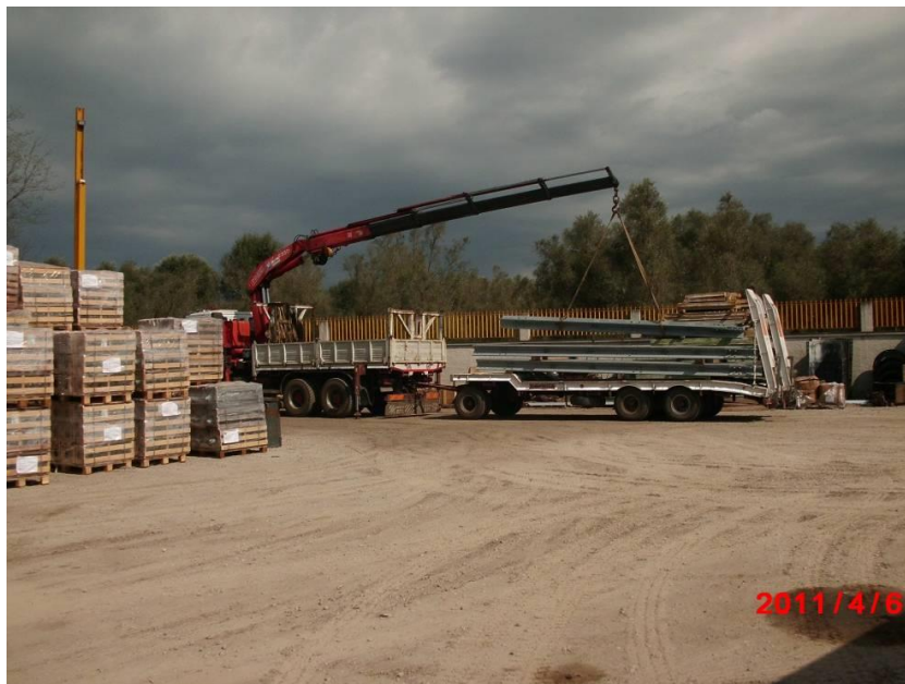
Figura 2.2.1-3 – Esempio di area centrale, scarico materiale
