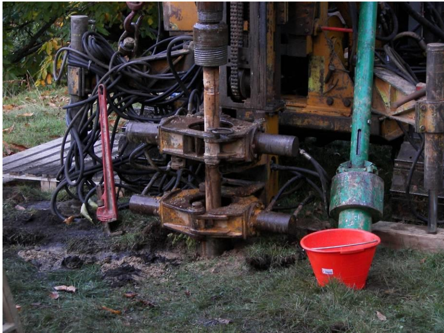
Figura 2.2.2-11 – Macchina operatrice per la realizzazione di micropali tubfix; sistema di scavo a rotopercussione
