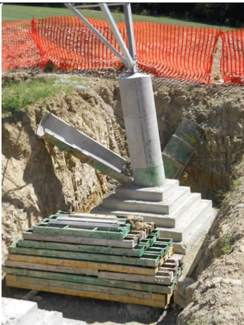
Figura 2.2.2-1 – Esempi di realizzazione delle fondazioni superficiali
