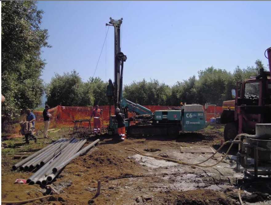
Figura 2.2.2-13 – Esempio di cantiere per la realizzazione dei micropali
