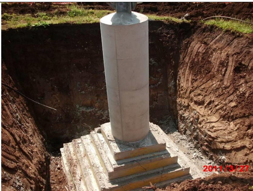
Figura 2.2.2-3 – Altri esempi di realizzazione delle fondazioni superficiali dei sostegni
