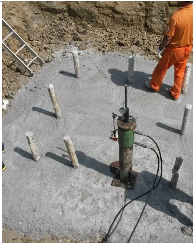
Figura 2.2.2-13 – Esempio di realizzazione dei micropali
