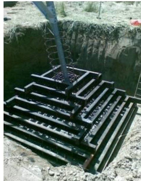
Figura 2.2.2-2 – Esempio di realizzazione di una fondazione a plinto con riseghe. Nell'immagine di sinistra di può osservare un disegno di progetto mentre nell'immagine di destra la fase di casseratura della fondazione
