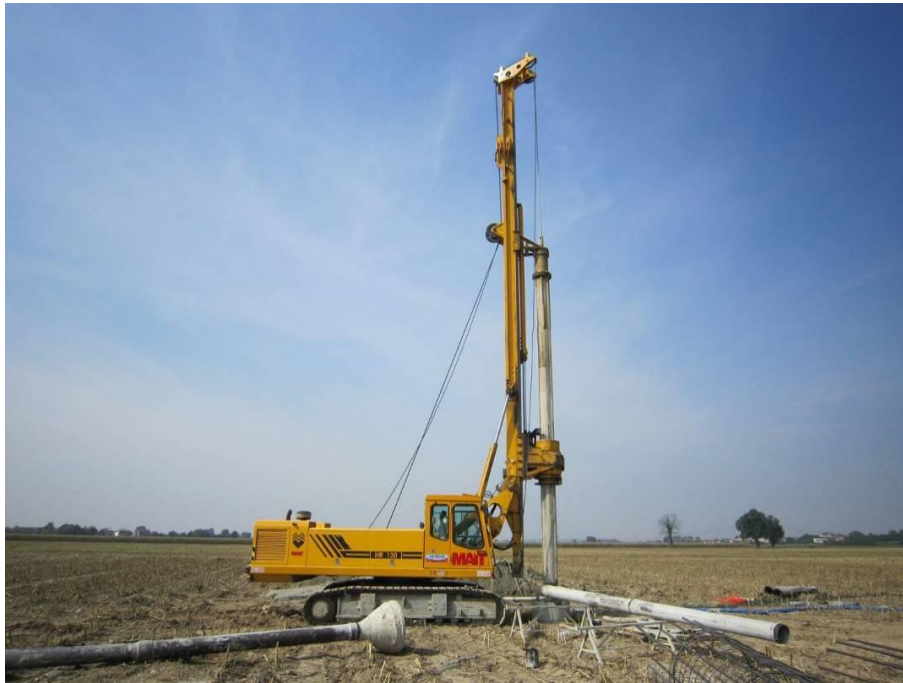
Figura 2.2.2-6 – Macchina operatrice per la realizzazione di pali trivellati
