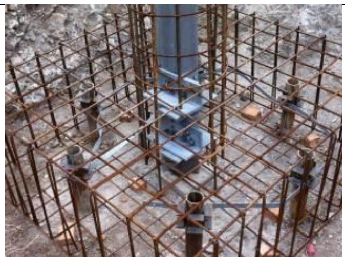
Figura 2.2.2-10 – Esempio di realizzazione di una fondazione su micropali tipo tubfix. Nell'immagine di destra si può notare il particolare del raccordo tra i tubolari metallici dei micropali con l'armatura del plinto di fondazione; al centro del plinto si nota il moncone del sostegno (elemento di raccordo tra il sostegno e la fondazione) il quale viene annegato nella fondazione stessa
