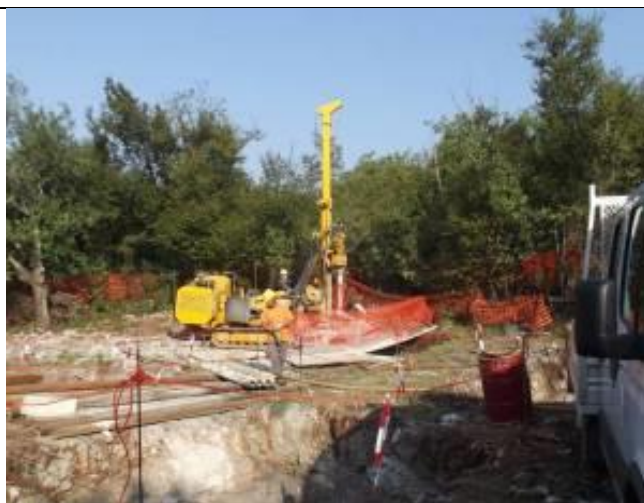
Figura 2.2.2-10 – Esempio di realizzazione di una fondazione su micropali tipo tubfix. Nell'immagine di destra si può notare il particolare del raccordo tra i tubolari metallici dei micropali con l'armatura del plinto di fondazione; al centro del plinto si nota il moncone del sostegno (elemento di raccordo tra il sostegno e la fondazione) il quale viene annegato nella fondazione stessa
