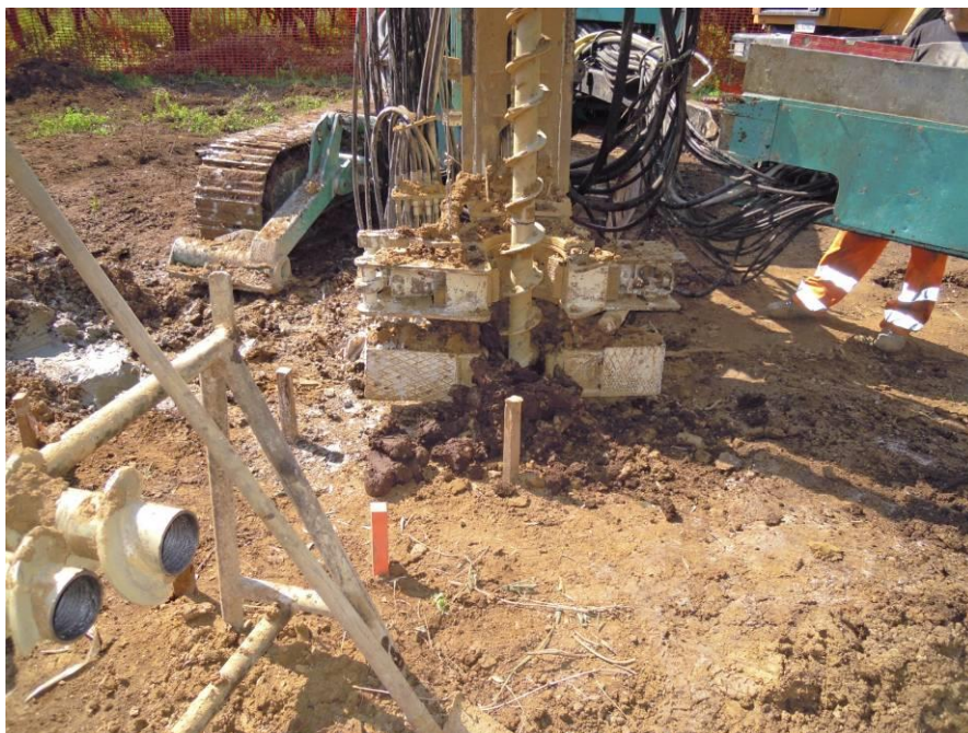
Figura 2.2.2-12 – Macchina operatrice per la realizzazione di micropali tubfix; sistema di scavo mediante trivella elicoidale
