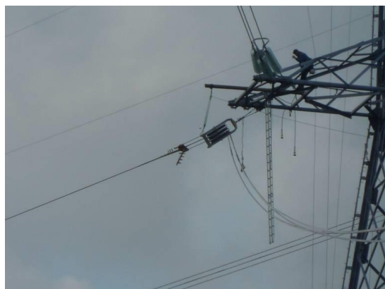
Figura 2.2.4-2 – Fasi di tesatura della linea elettrica
