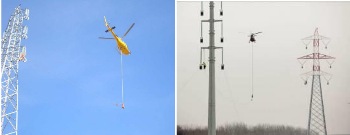
Figura 2.2.4-1 – Utilizzo dell'elicottero per stesura della fune pilota
