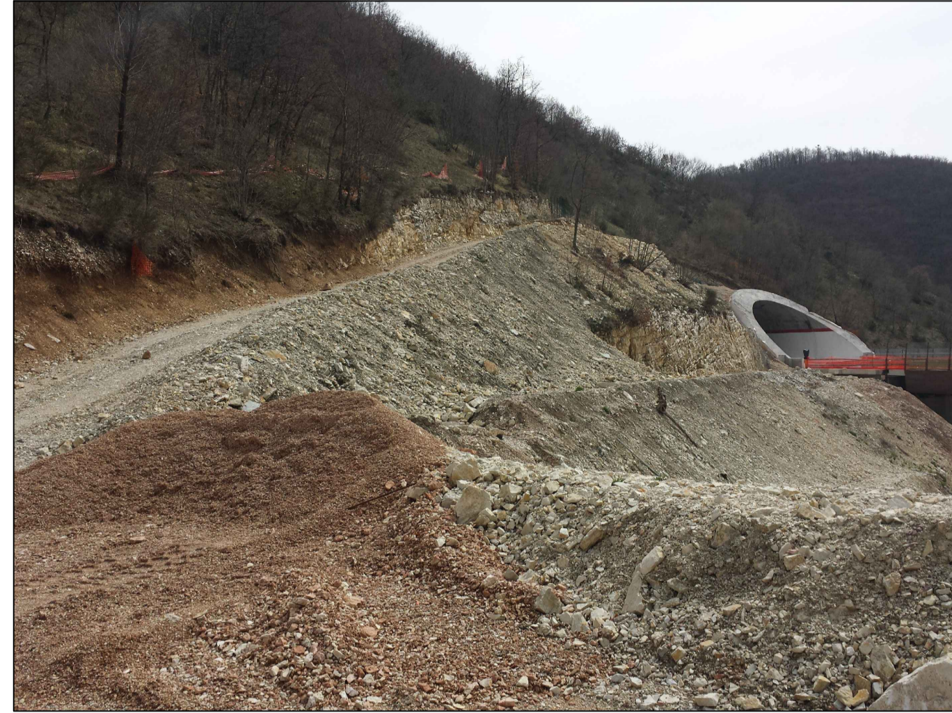
FOTO 1: VISTA TRACCIATO PISTA 10
