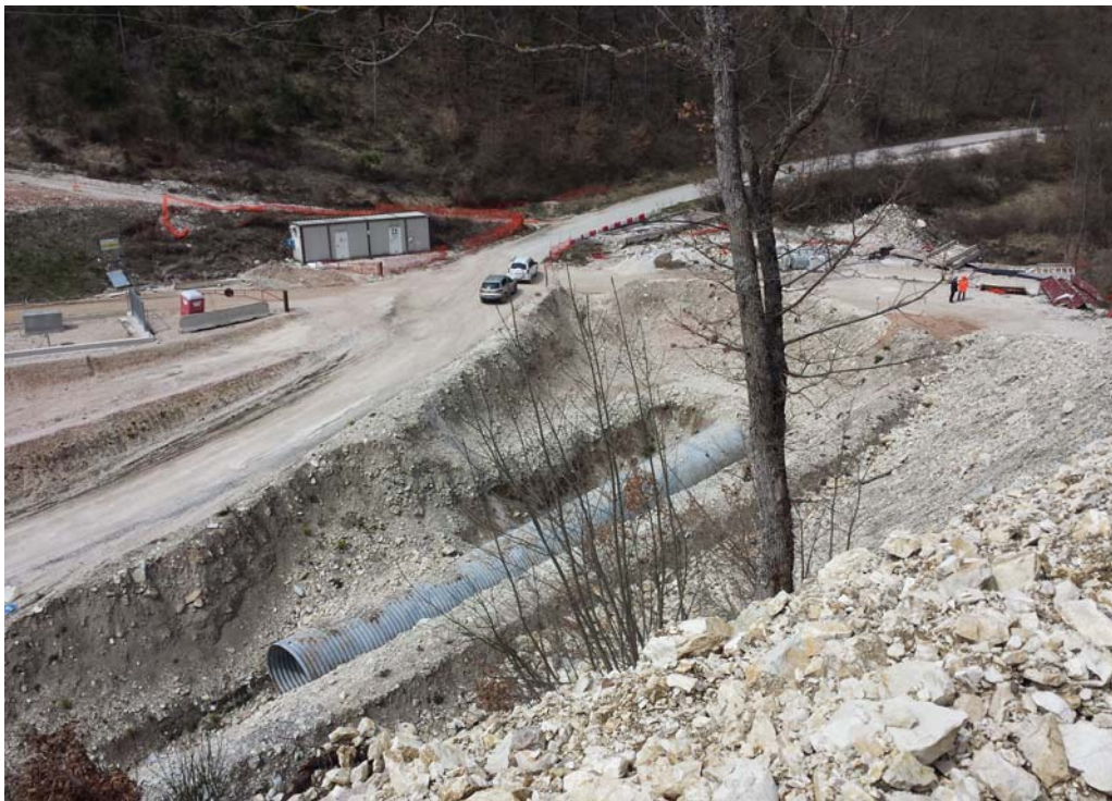
Figura 10 - Immagine della pista in fase di produzione
