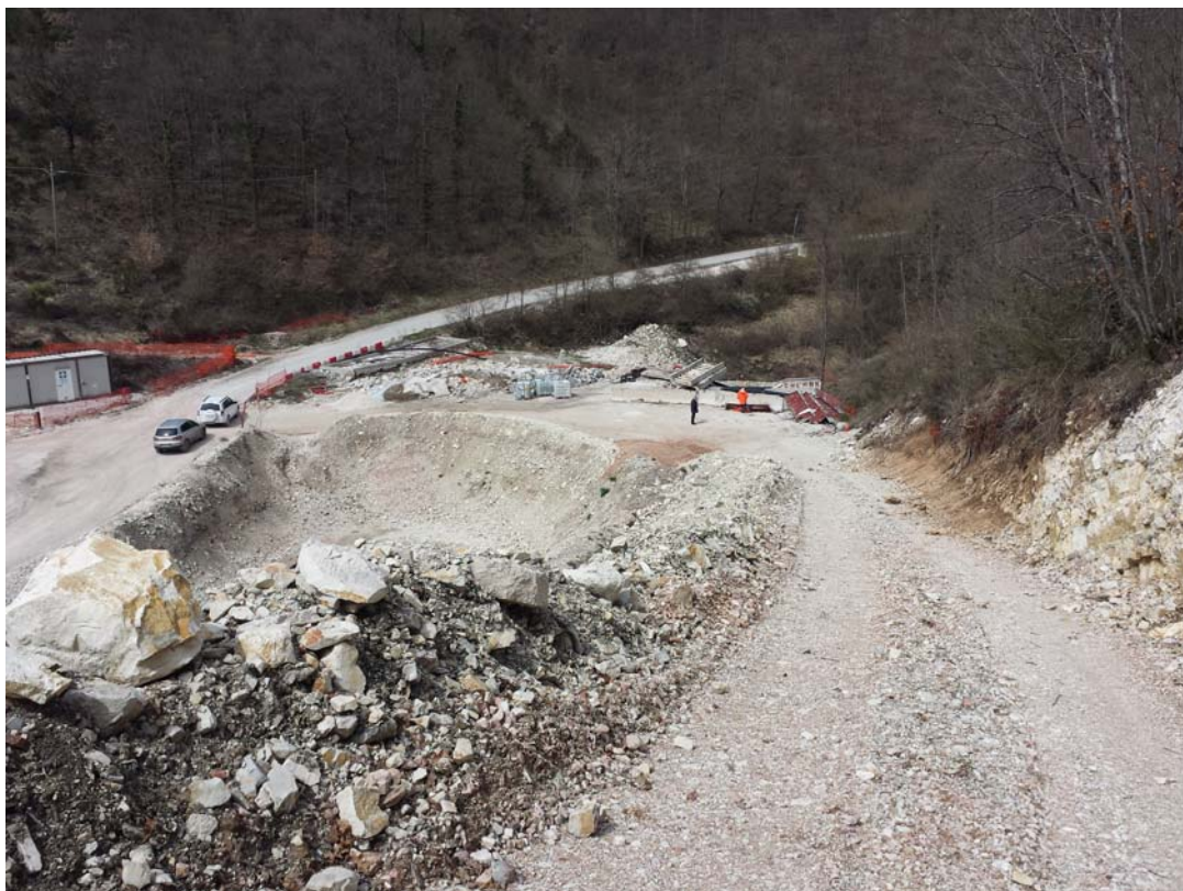
Figura 11 - Immagine della pista in fase di produzione
