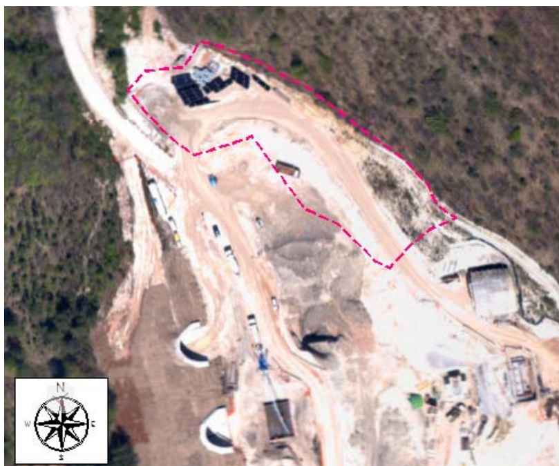
Figura 3 - Ortofoto d'inquadrimento del sito "Pista 10" tratto da Google Earth
