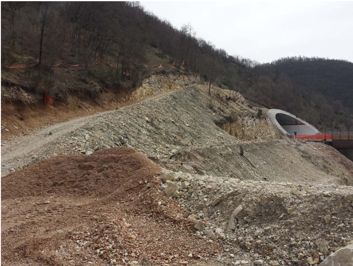
Figura 8 - Immagine della pista in fase di produzione
