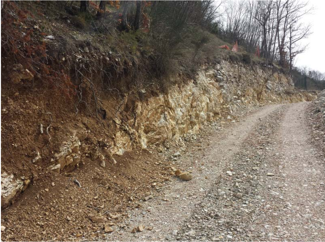
Figura 9 - Immagine della pista in fase di produzione
