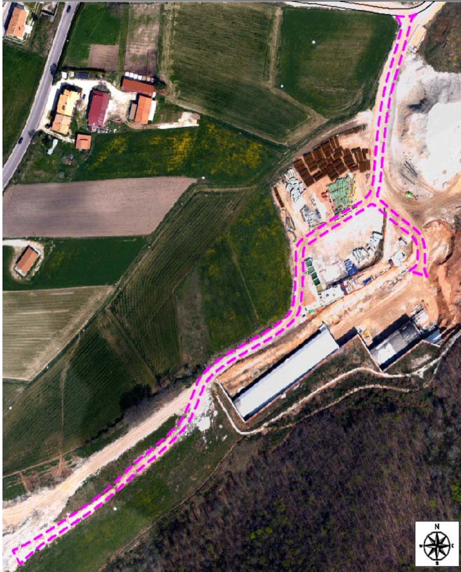
Figura 3 - Ortofoto d'inquadramento del sito "Pista 12" tratto da Google Earth
