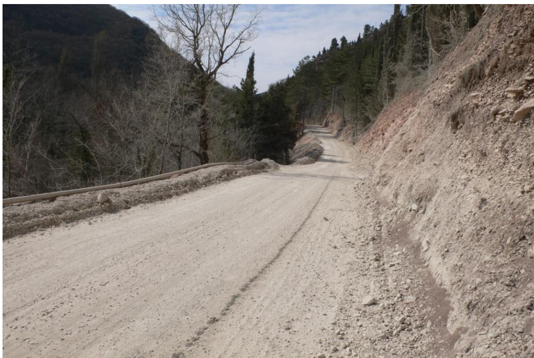
Figura 6 - Immagine della pista in fase di produzione
