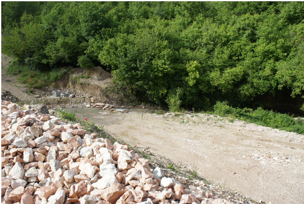
Figura 6.a - Immagine dell'area in fase di cantiere
