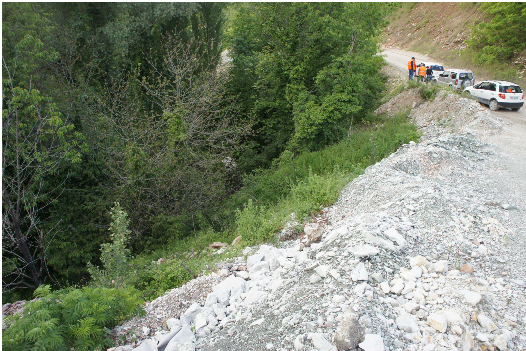
Figura 6.c - Immagine dell'area in fase di cantiere
