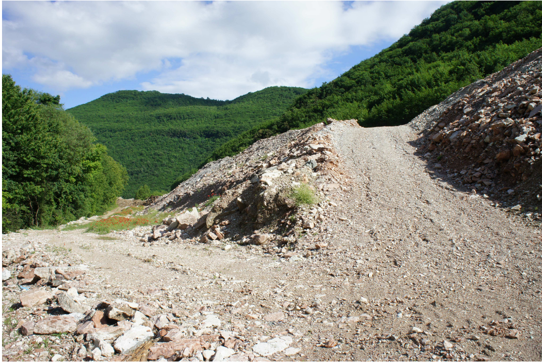
Figura 6.b - Immagine dell'area in fase di cantiere
