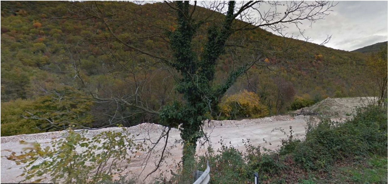
Figura 6.d - Immagine dell'area in fase di cantiere
