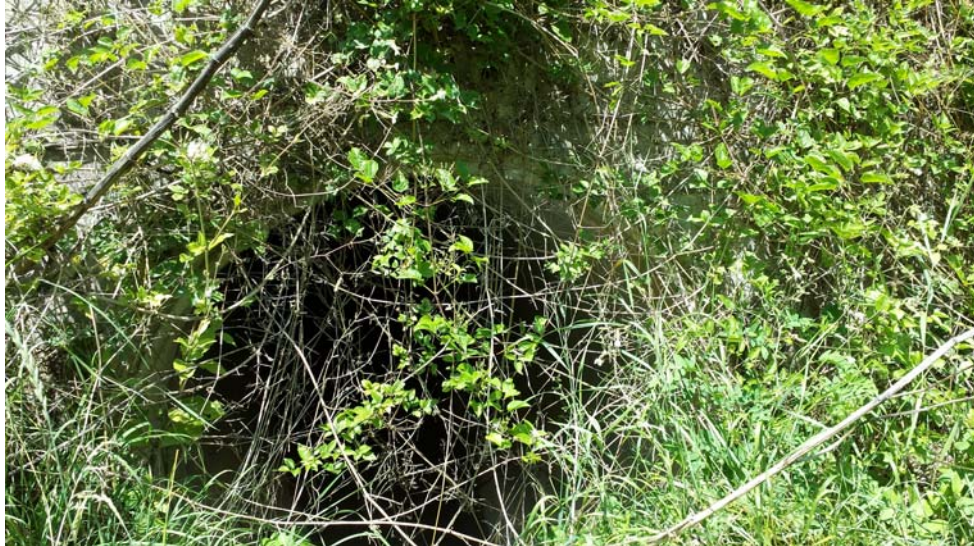
Foto 5 _Tombamento del fosso Bottegaia sotto la SS77 – lato monte (PC1)
