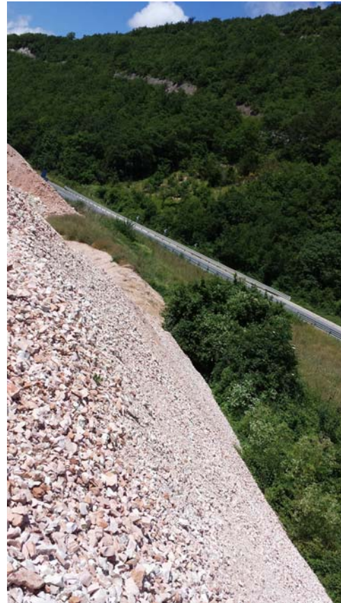
Foto 2 _Fosso Bottegaia in area PC1 tra i cumuli e la SS 77
