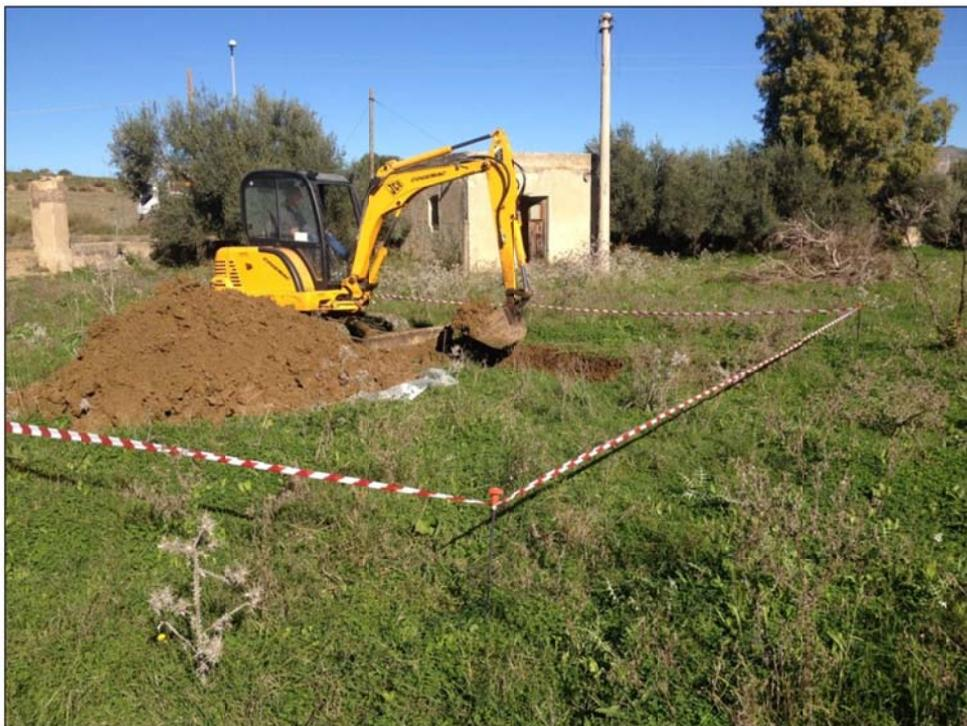
Il completamento dello scavo con pareti verticali rasate è stato eseguito per favorire il rilievo pedologico e la parametrizzazione chimico-fisica richiesta. Le superfici scelte per la descrizione, infatti, sono state ripulite accuratamente a “coltello” per evidenziare i caratteri tessiturali, strutturali e composizionali del suolo. All’interno dello scavo non è stata rilevata una falda superficiale.
