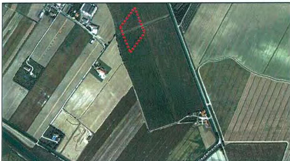
Figura 17 Vista aerea dell'area destinata al cantiere base (Ortofoto da Google Earth).
