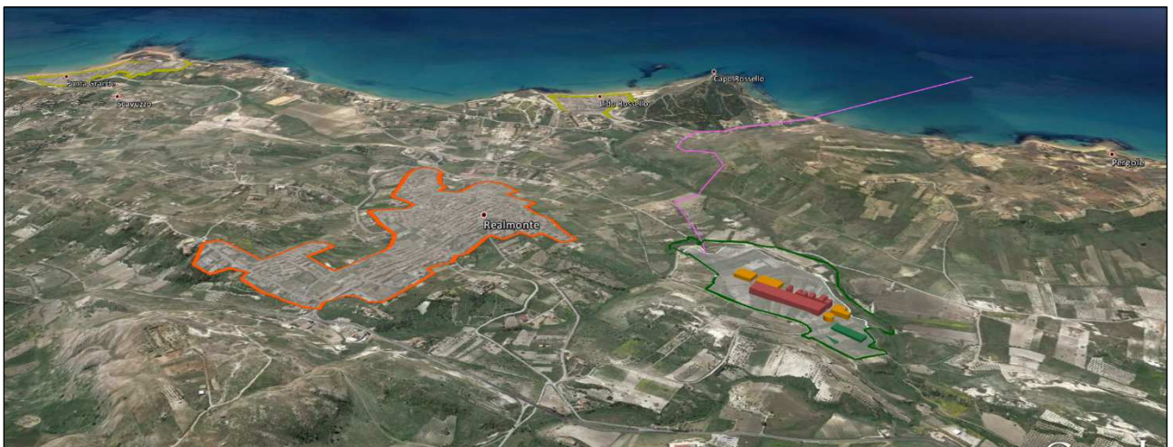
Fig. 50 - Vista aerea Nord-Sud del centro abitato di Realmonte.
