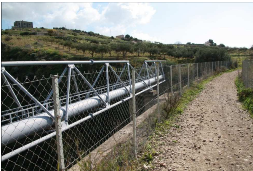
Fig. 32 - Acquedotto Sovrambito Favara di Burgio.
