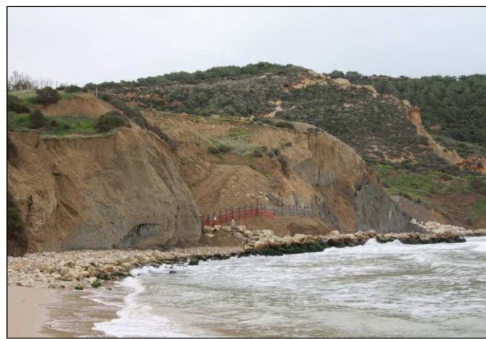
Fig. 24 - Evidenze dei fenomeni franosi presenti ad est della foce del V. ne Grande.
