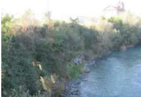
Il fiume a monte del ponte canale
