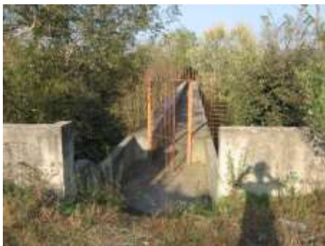
Il ponte canale sulla Dora
