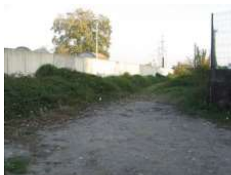
La strada sterrata che fianeggia la stazione elettrica, ripresa da N
