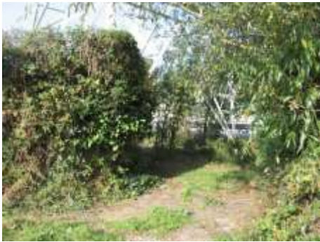
Il traliccio a cui si conetterà il cavidotto
