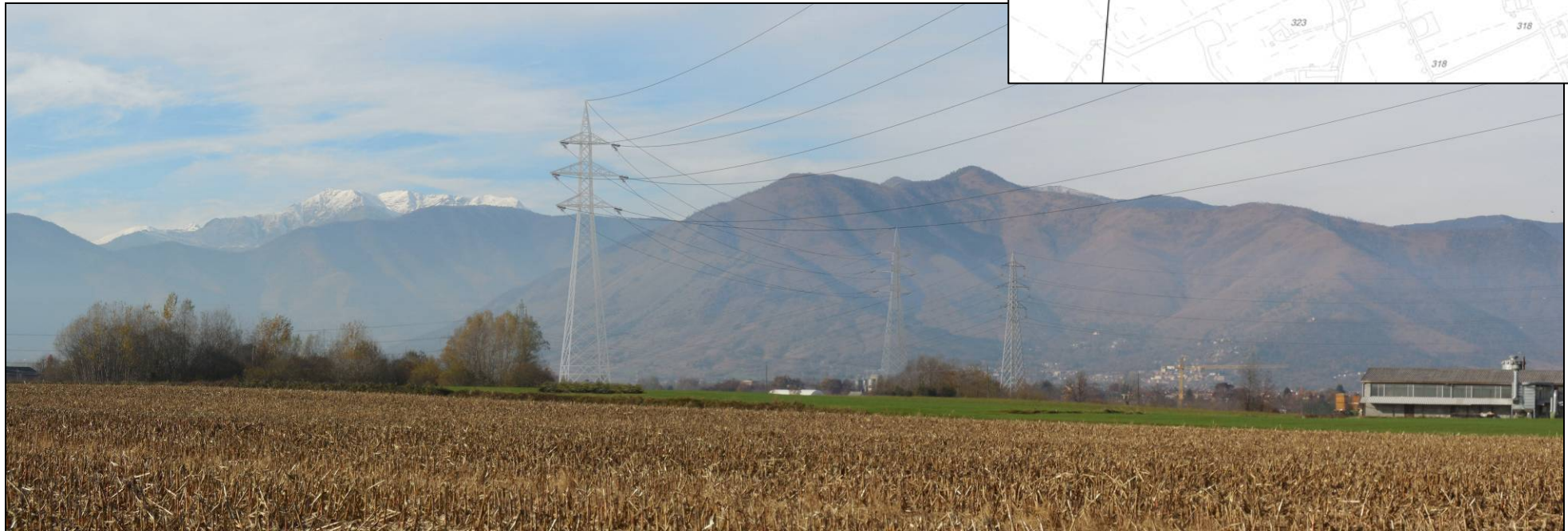
Fotoinserimento 2: Linee T.231-T.216 – Situazione di progetto - La visuale corrisponde al tratto in corrispondenza dei futuri sostegni P15N-P130N e P16N-P129N; in questo tratto il tracciato viene deviato per allontanare la linea elettrica dall'insediamento produttivo collocato sulla destra
