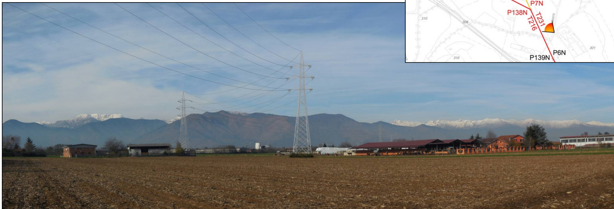
Fotoinserimento 1: Linee T.231-T.216 – Situazione di progetto - La visuale corrisponde al tratto in corrispondenza dei futuri sostegni P7N-P138N e P8N-P137N; in questo tratto il tracciato viene deviato per allontanare la linea elettrica dall'insediamento rurale-residenziale collocato sulla destra
