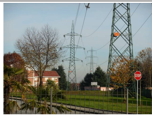
6. Sostegno P30, tra i sostegno P29 e P31
