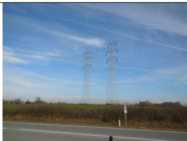
8. Sostegno P12 sulla destra, a fianco la linea T.595
