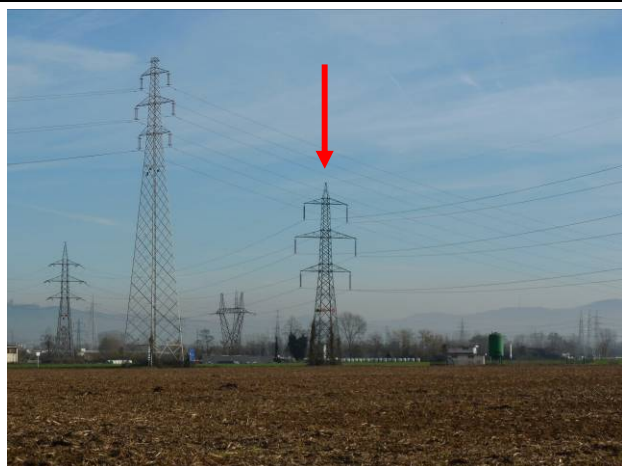
1. Sostegno P25, in corrispondenza dell'attraversamento della linea T.231
