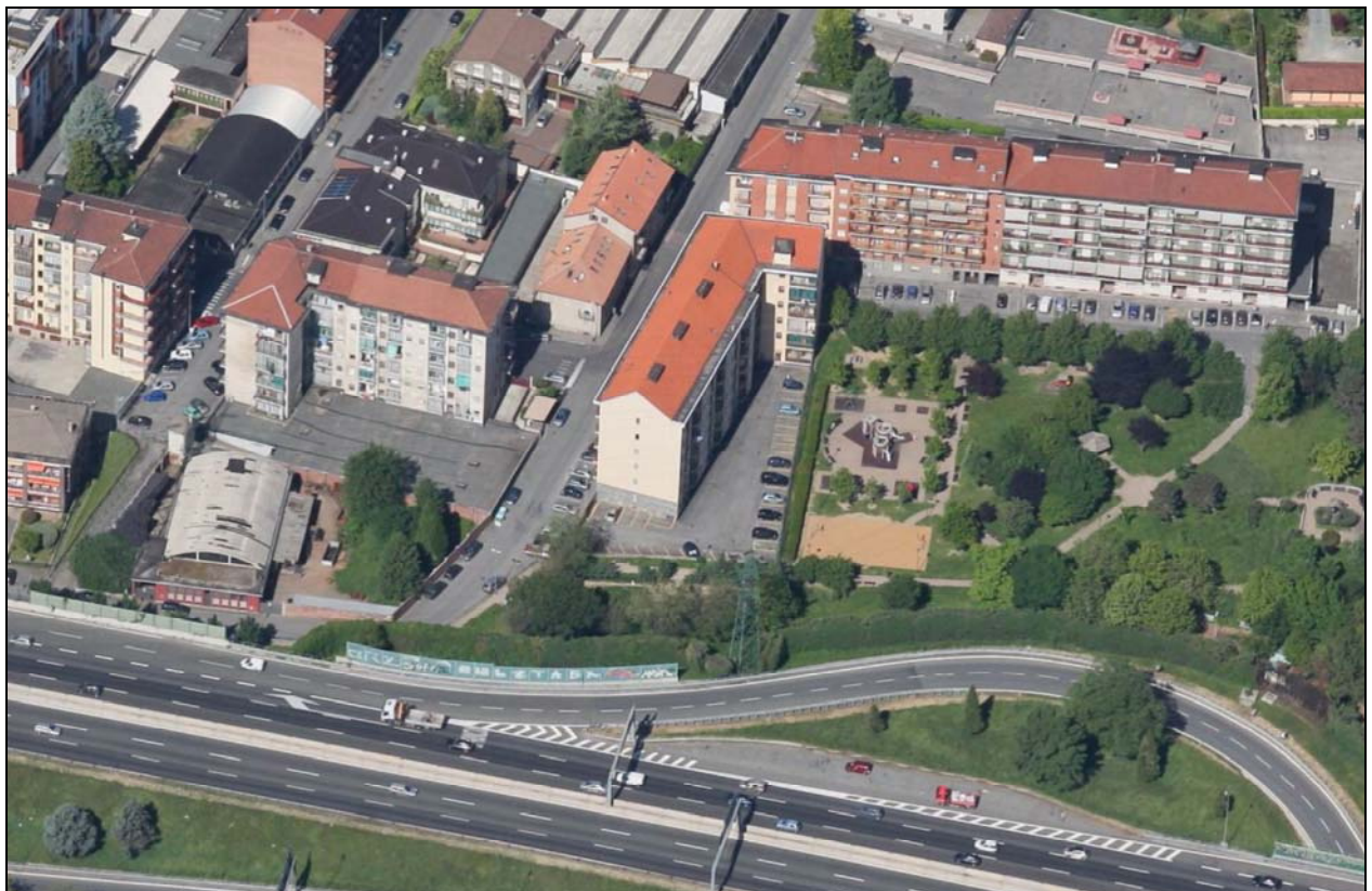
Fotoinserimento 5: Linea T.216-T.217 – La ripresa fotografica (fonte: Bing maps) illustra gli effetti derivanti dalla demolizione dell'elettrodotto esistente in Comune di Rivoli nel tratto di attraversamento delle zone densamente insediate a ridosso dell'autostrada Tangenziale di Torino
