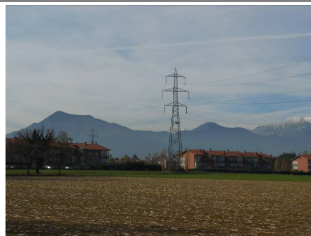
4. Sostegno P28, sulla sinistra sostegno P29
