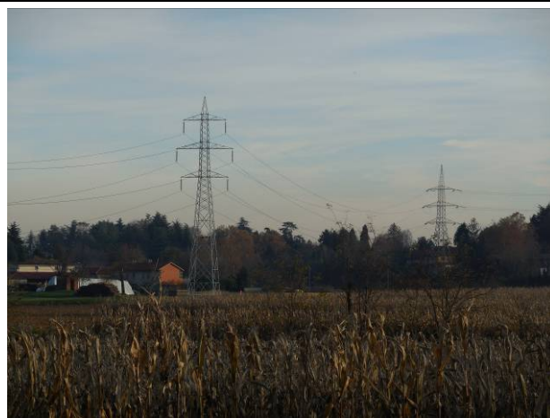
8. Sostegni P142, a sinistra , e P143
