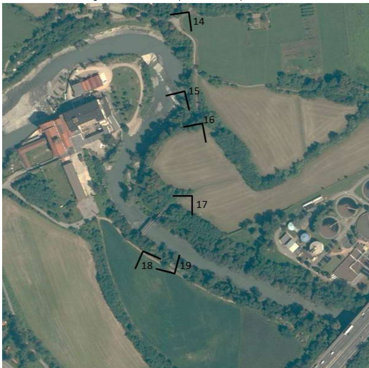
Figura 13 – Foto aerea ponte-canale – punti di vista
