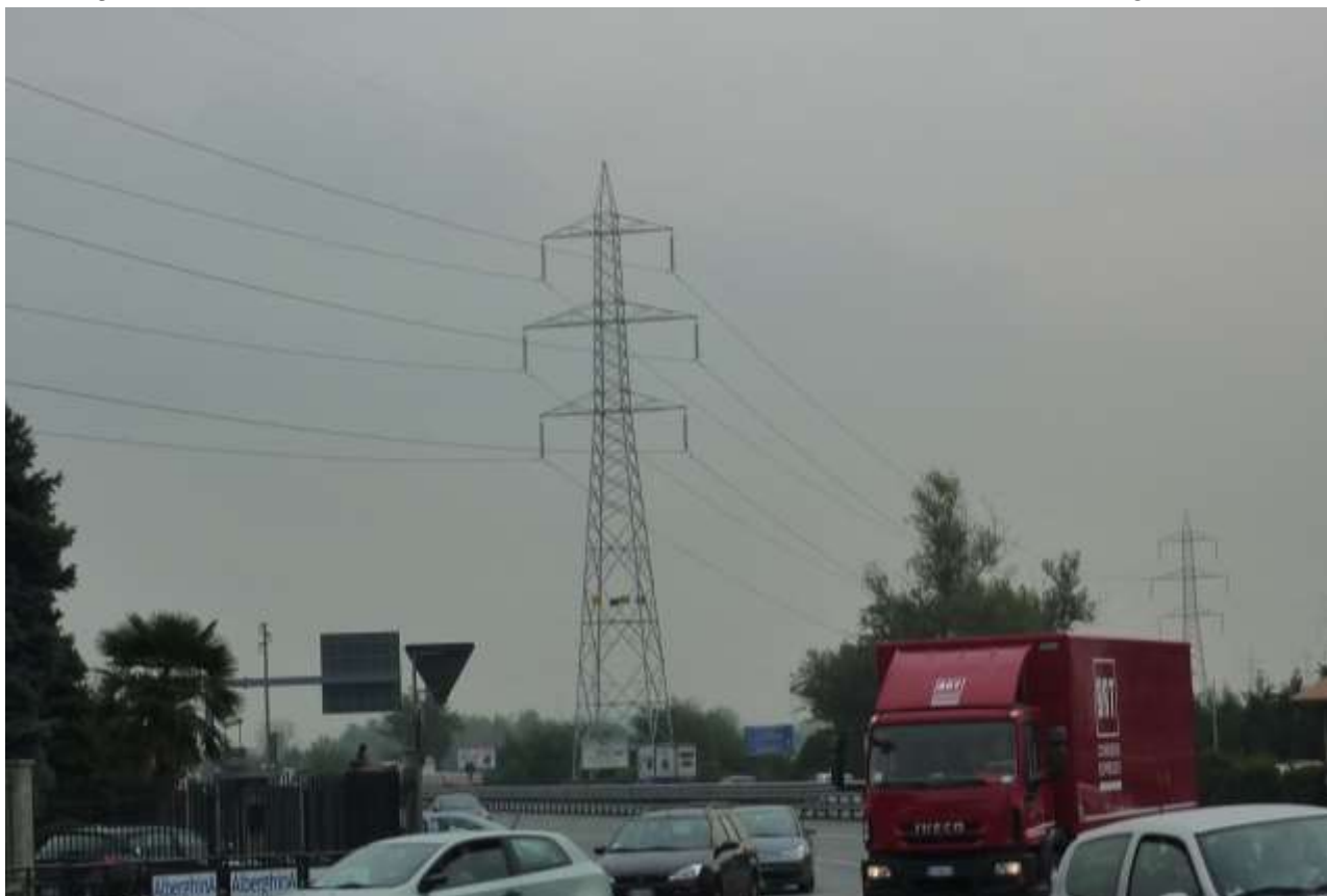
Figura 28 – Vista da nord, all’incrocio tra via Pavia e corso Allamano, sul sostegno n. 154
