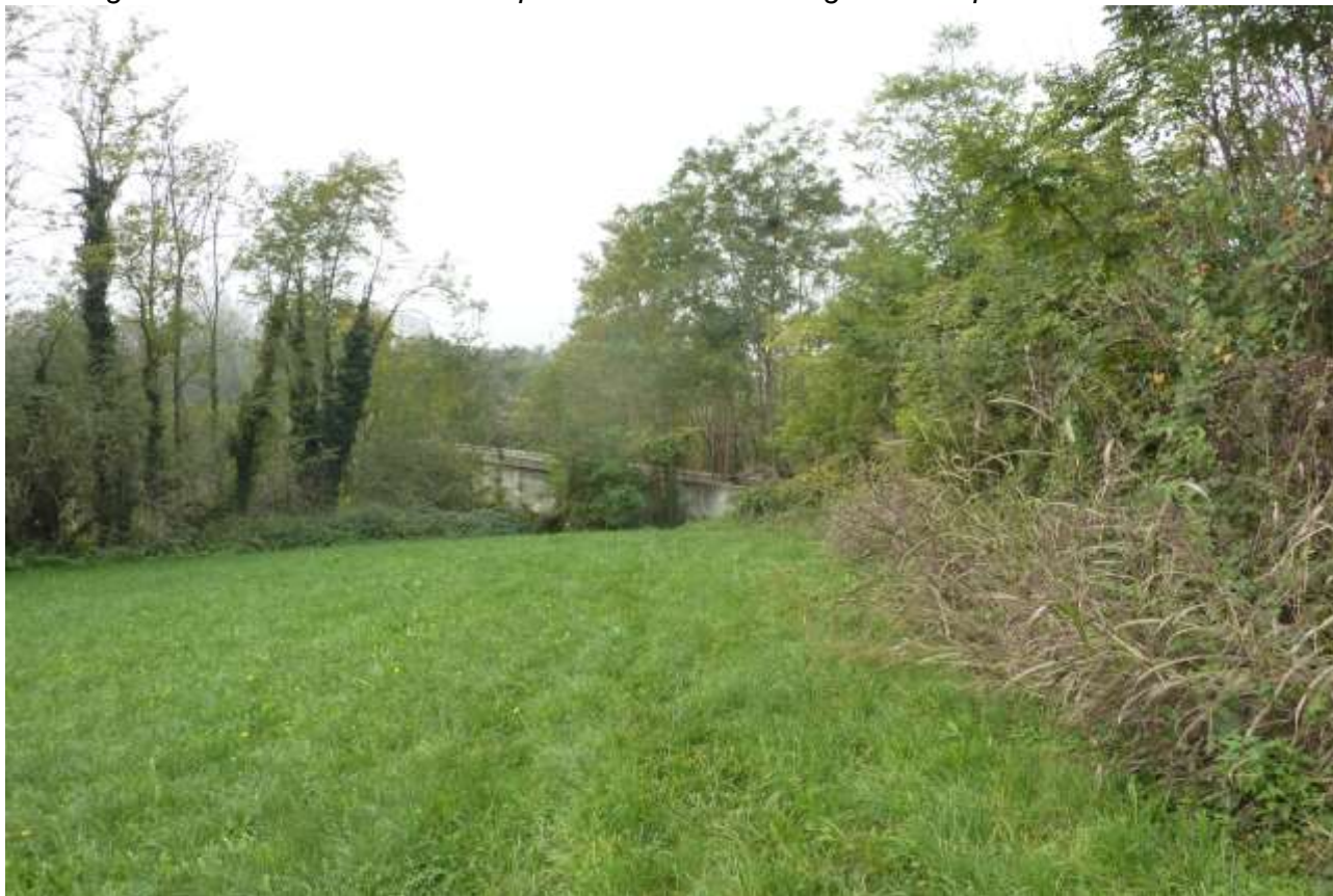
Figura 13 – Vista da sud-est sul ponte-canale che collega le due sponde del fiume Dora
