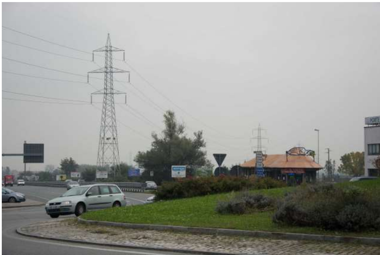
Figura 52 – Vista da nord-ovest del traliccio n. 154 – stato attuale
