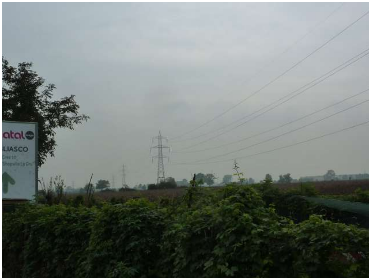
Figura 5 – Foto della campata oggetto di intervento – stato attuale
