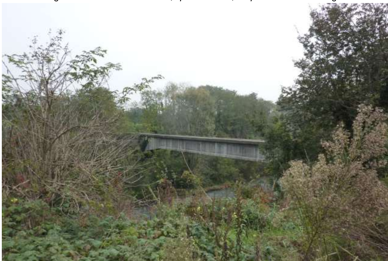
Figura 16 – Vista da nord-ovest, sponda destra, sul ponte-canale – Collegno
