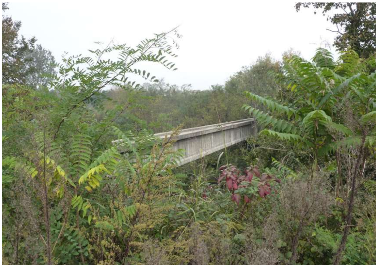
Figura 19 – Vista del ponte-canale da sud-est
