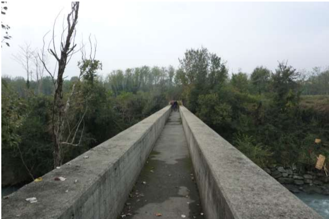
Figura 15 – Vista del ponte-canale
