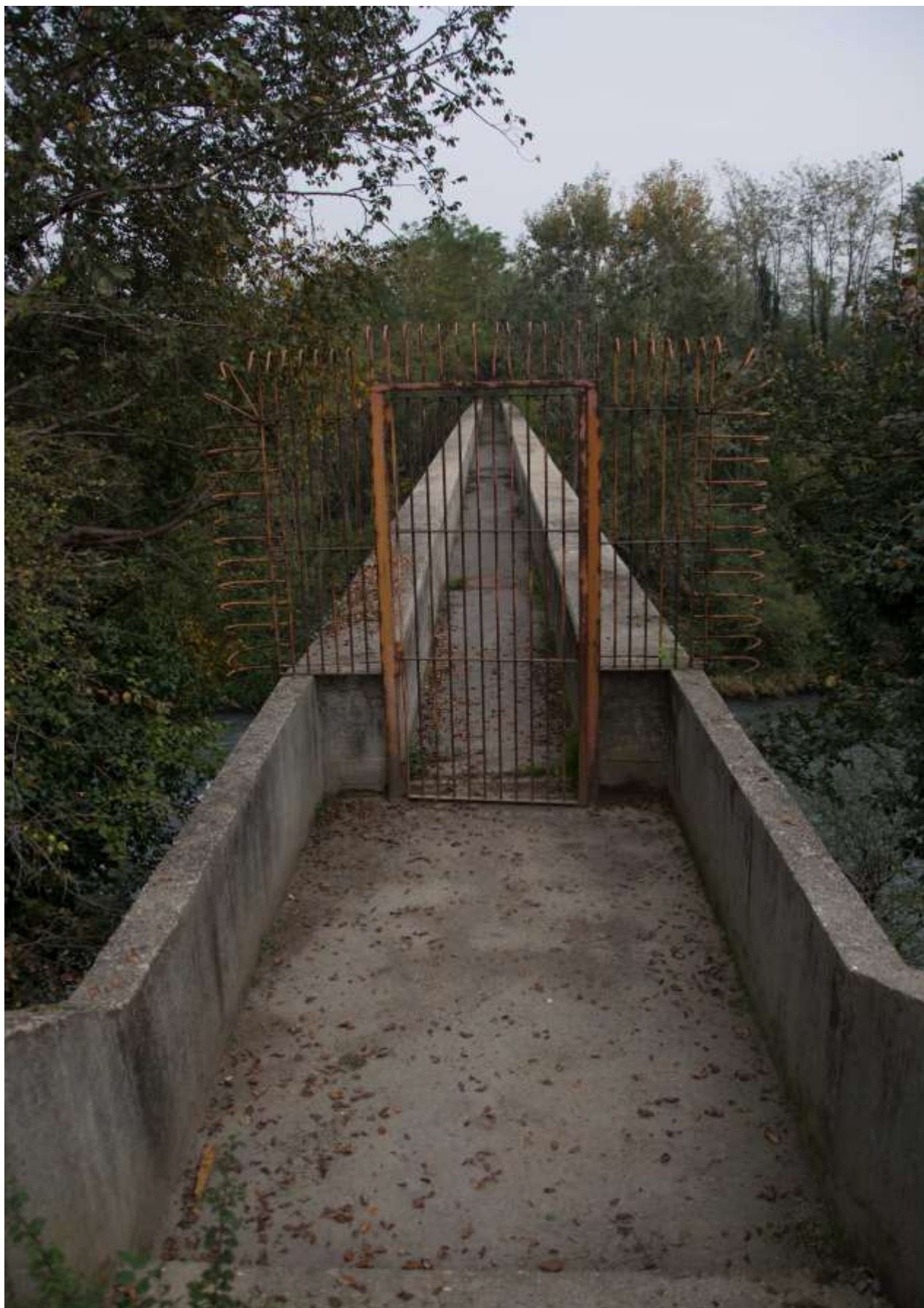
Figura 50 – Vista da sud dell'accesso al ponte-canale – stato attuale
