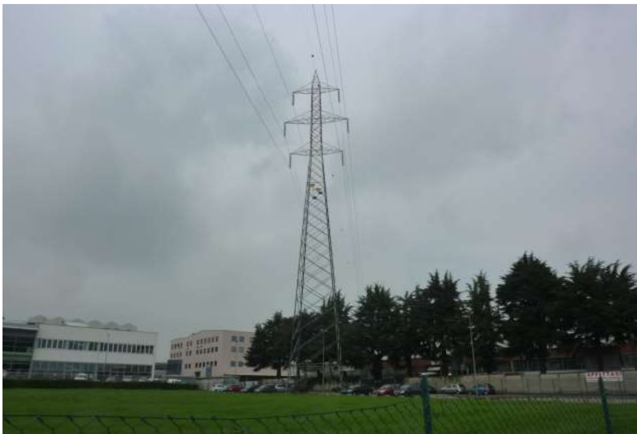
Figura 27- Vista da sud-est da Via pavia verso il traliccio 153
