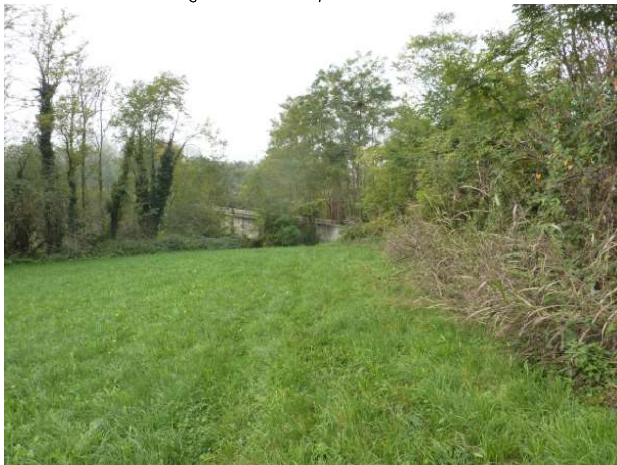
Figura 17 – Vista del ponte-canale da est
