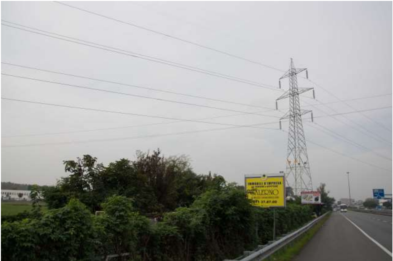
Figura 54 – Vista da est del traliccio n. 154 – stato attuale
