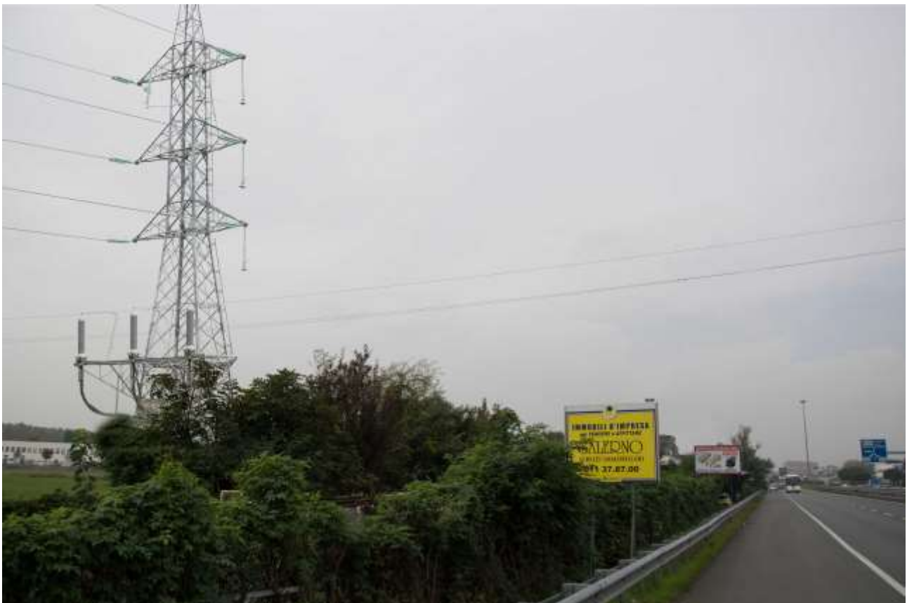
Figura 55 – Vista da est del traliccio n. 154 – progetto
