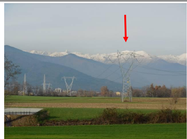
4. Sostegno P129, sulla sinistra l'allineamento dei sostegni fino all'attraversamento della linea T.231
