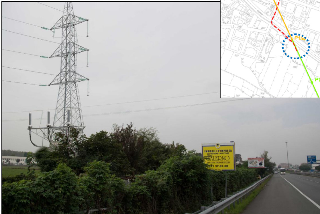
Fotoinserimento 6 – Linea T.213 Vista del traliccio n. 154 – stato attuale e stato di progetto come sostegno portaterminali. Il sostegno costituisce il punto di raccordo tra il tratto in cavo di nuova realizzazione e il tratto residuo del tracciato delle linee T.216-T.217, tra di loro integrate, che raggiunge la Stazione Elettrica di Grugliasco. Il sostegno rappresenta si colloca lungo un corridoio di elevata percezione visiva (corso Allamano).
