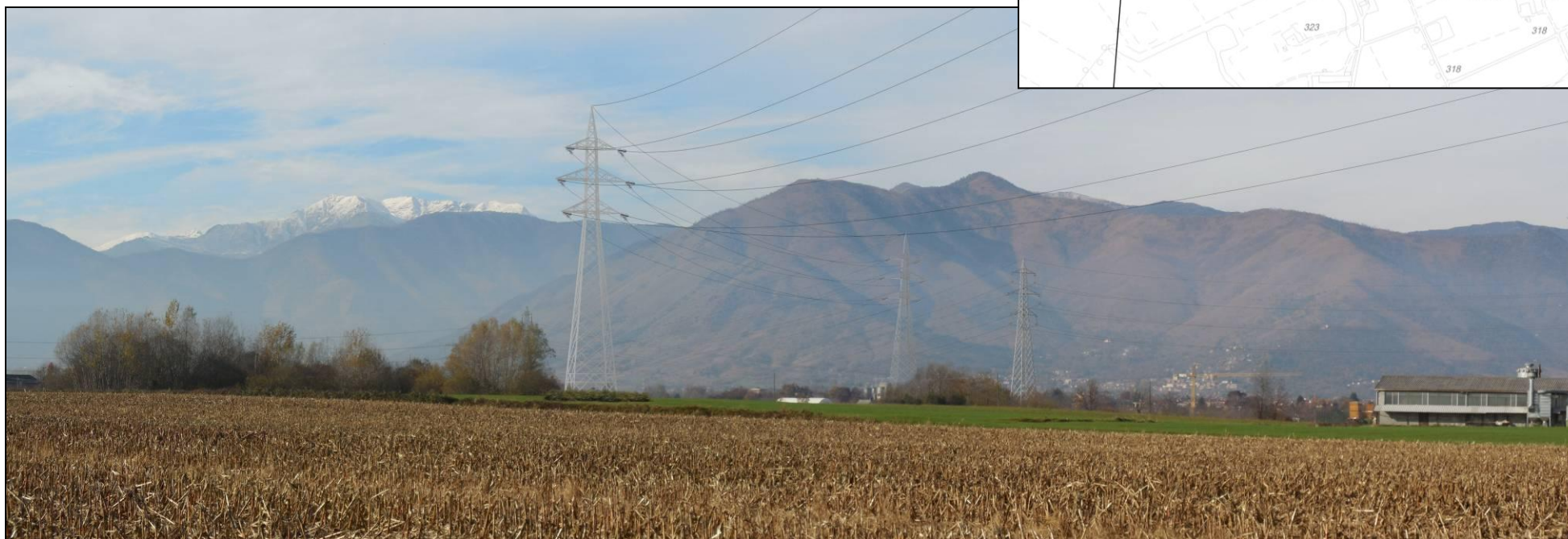
Fotoinserimento 2: Linee T.231-T.216 – Situazione di progetto - La visuale corrisponde al tratto in corrispondenza dei futuri sostegni P15N-P130N e P16N-P129N; in questo tratto il tracciato viene deviato per allontanare la linea elettrica dall'insediamento produttivo collocato sulla destra
