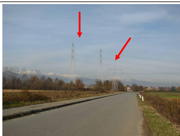
14. Sostegno P15 (P19N) sulla sinistra, a fianco la linea T.595, in basso il sostegno P126 (P126N) della T.216
