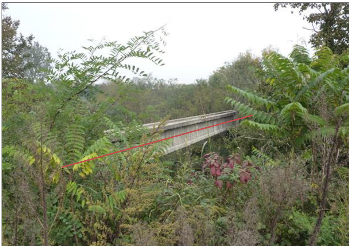
14. Attraversamento della Dora Riparia in corrispondenza dell'esistente ponte canale
