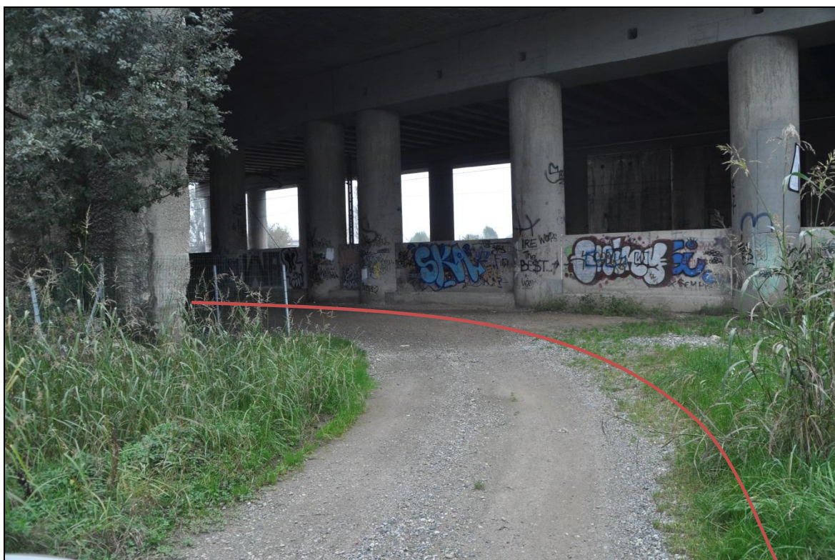
21. In prosecuzione di via Chieri, imbocco del sottopasso di attraversamento della Tangenziale Nord
