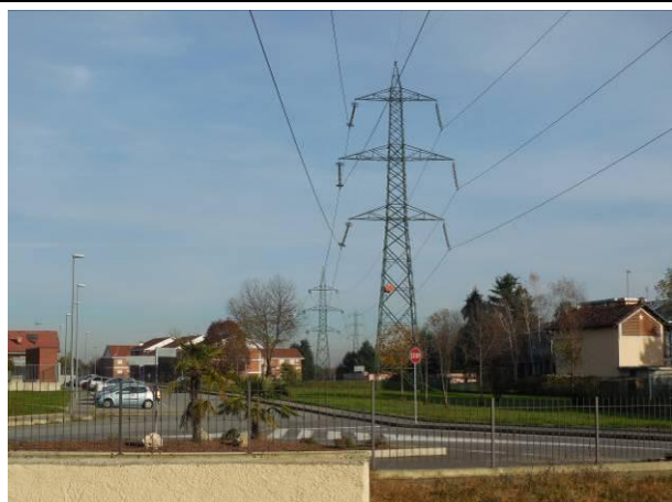
7. In primo piano il sostegno P31, sullo sfondo i sostegni P30 e P.29
