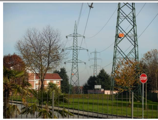
6. Sostegno P30, tra i sostegno P29 e P31
