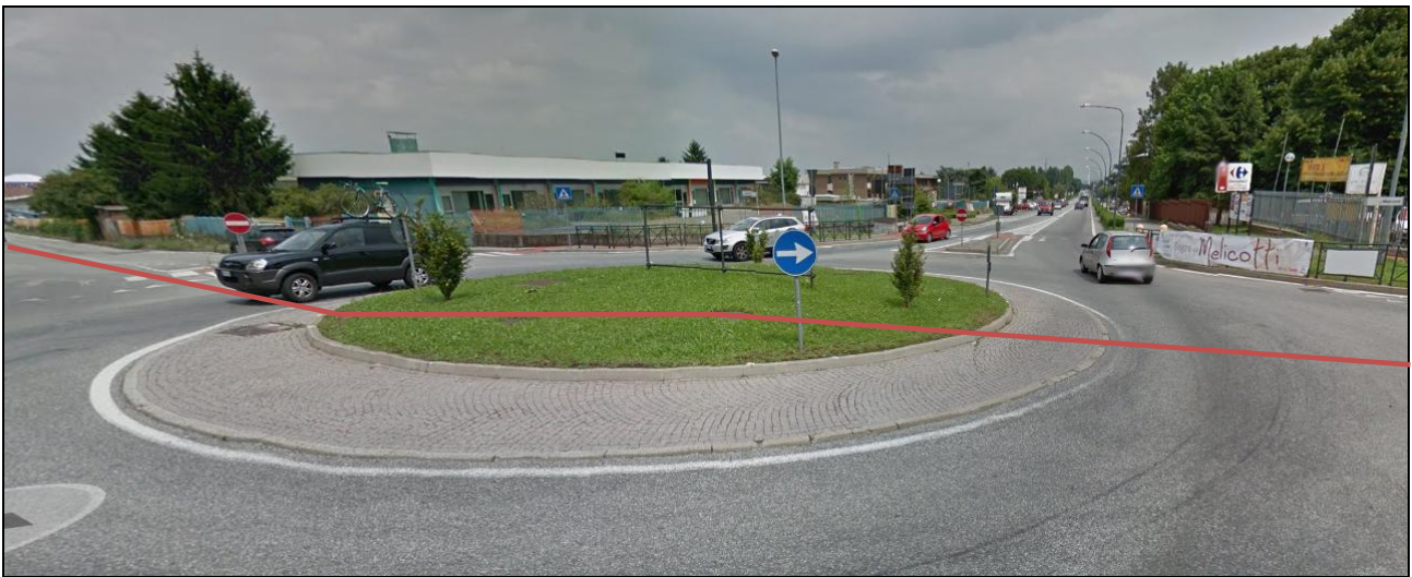
7. Attraversamento rotonda incrocio con via Torino – via Pianezza
