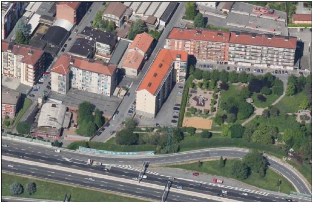
Fotoinserimento 5: Linee T.216-T.217 – La ripresa fotografica (fonte: Bing maps) illustra gli effetti derivanti dalla demolizione dell'elettrodotto esistente in Comune di Rivoli nel tratto di attraversamento delle zone densamente insediate a ridosso dell'autostrada Tangenziale di Torino
