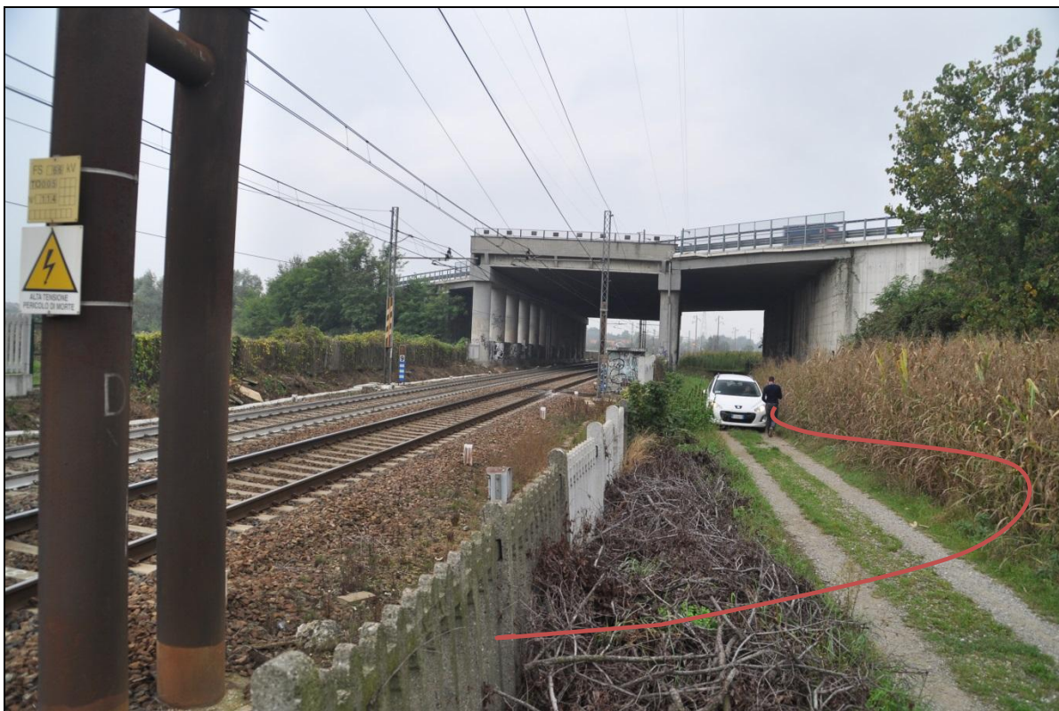
23. Attraversamento della ferrovia Torino-Modane tramite perforazione con spingitubo
