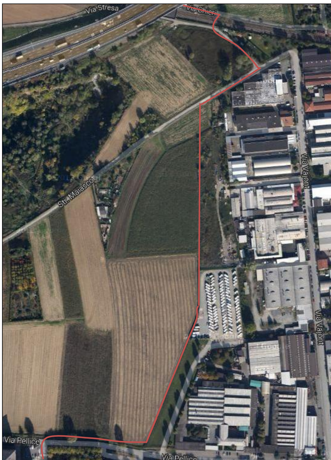
25. Attraversamento del terreno agricolo fra via Maiasco e via Pellice (comune di Rivoli)
