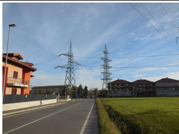
8. Sostegno P32, sulla sinistra, e P32 bis
