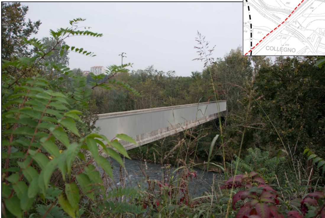
Fotoinserimento 7 – Linea T.213 attraversamento della Dora Riparia. La fotosimulazione rappresenta la vista ravvicinata da sud-est del ponte-canale, da dove è possibile apprezzare il lato a valle interessato dalla modifica, e l'accesso al ponte da sud, da cui si vede il carter che protegge il cavo fissato al parapetto. Dalle due immagini appare chiaro come il passaggio fuori terra del cavo, grazie all'utilizzo del ponte-canale esistente, sia risolto senza incidere sui caratteri paesaggistici di pregio dell'ambito interessato.
