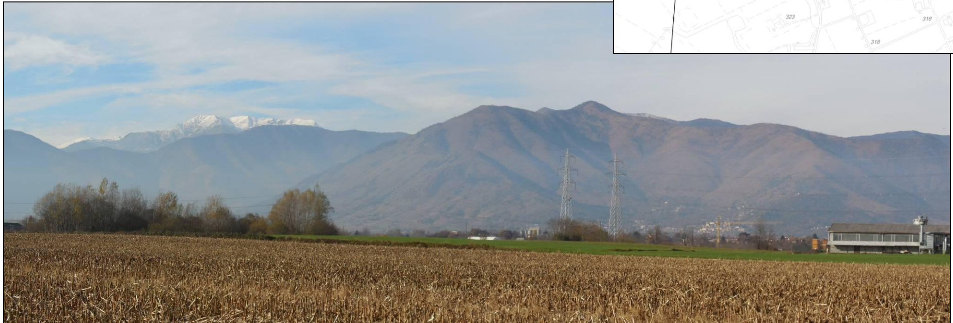
Fotoinserimento 2: Linee T.231-T.216 - Stato attuale - La visuale corrisponde al tratto in corrispondenza all'attuale sostegno P13 della linea T.231; in questo tratto il tracciato della linea si sviluppa parallelamente alla linea T.595
