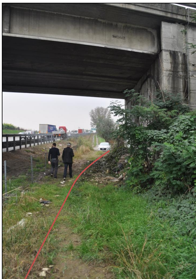
17. In affiancamento alla Tangenziale Nord sottopasso del cavalcavia di via Alpignano (comune di Collegno)
