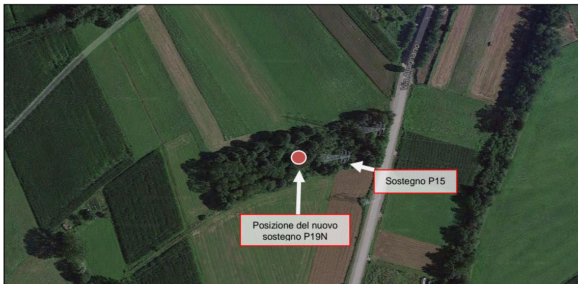
Figura 5.1/1 piccola area boscata interessata dalla realizzazione del nuovo sostegno P19N e dalla dismissione del sostegno P15 esistente
