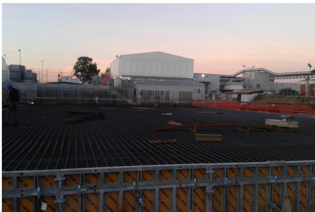
Figura 4.3/4: Vista della platea di fondazione completamente armata
