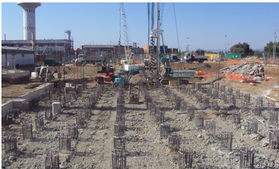
Figura 4.2/2: Panoramica della palificata del Deposito DMC3/DTC3
