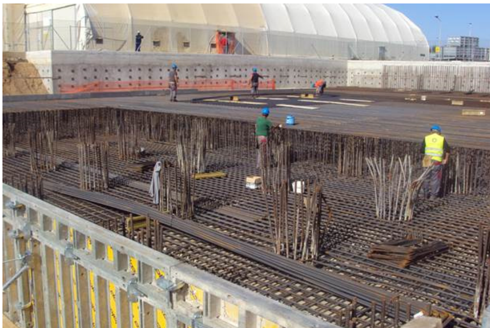
Figura 4.3/3: Montaggio armature della platea di fondazione
