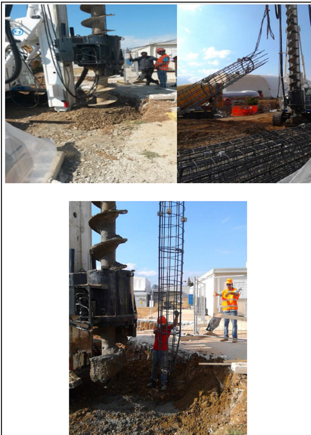
Figura 4.2/3: Sequenza di realizzazione palo
