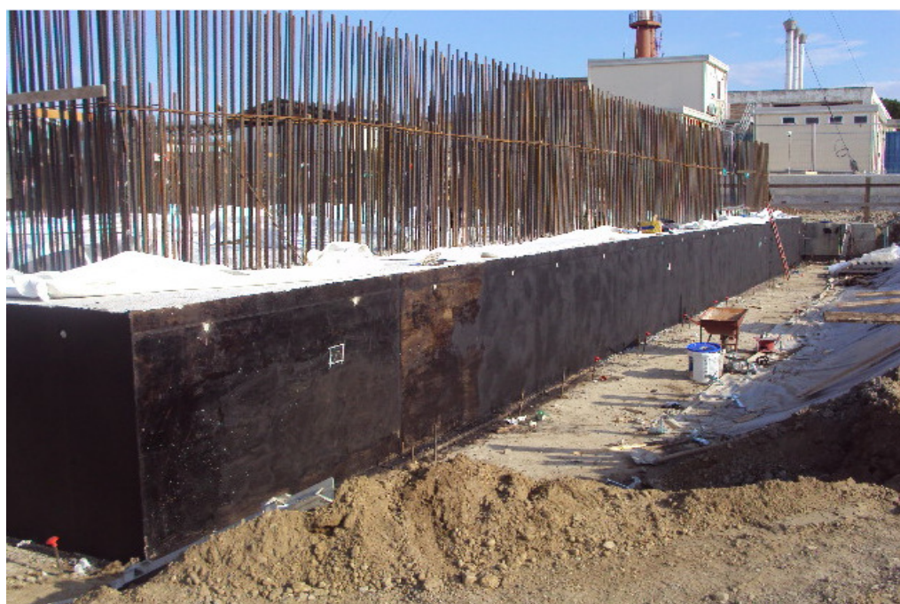
Figura 4.3/6: Vista della platea di fondazione durante la fase di cura
