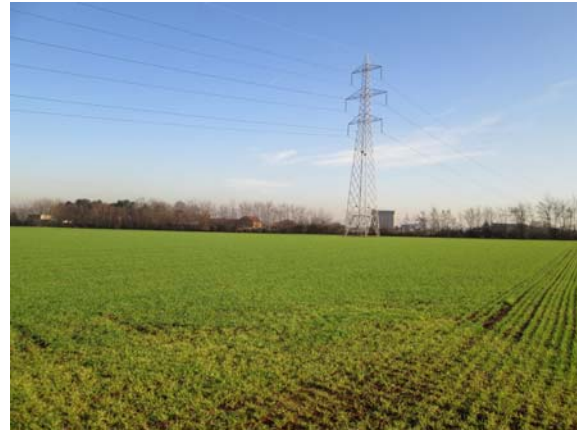
Fig. 8.4: Area del sostegno P7 da demolire dove è previsto il sostegno P9-136N
