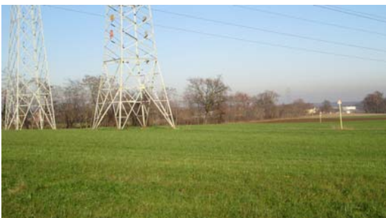
Fig. 8.16: Area di P17-128N e del sostegno P14 da demolire
