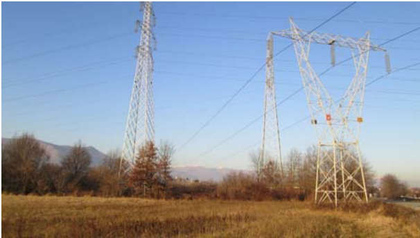
Fig. 8.18: Area del nuovo sostegno P19-126N e dei sostegni P15 e P126 da demolire
