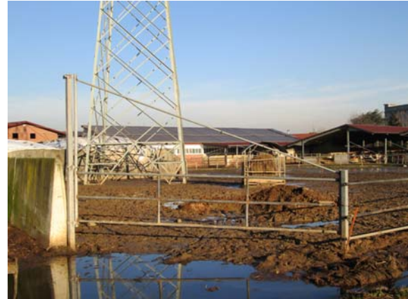
Fig. 8.2: Il sostegno P6 da demolire
