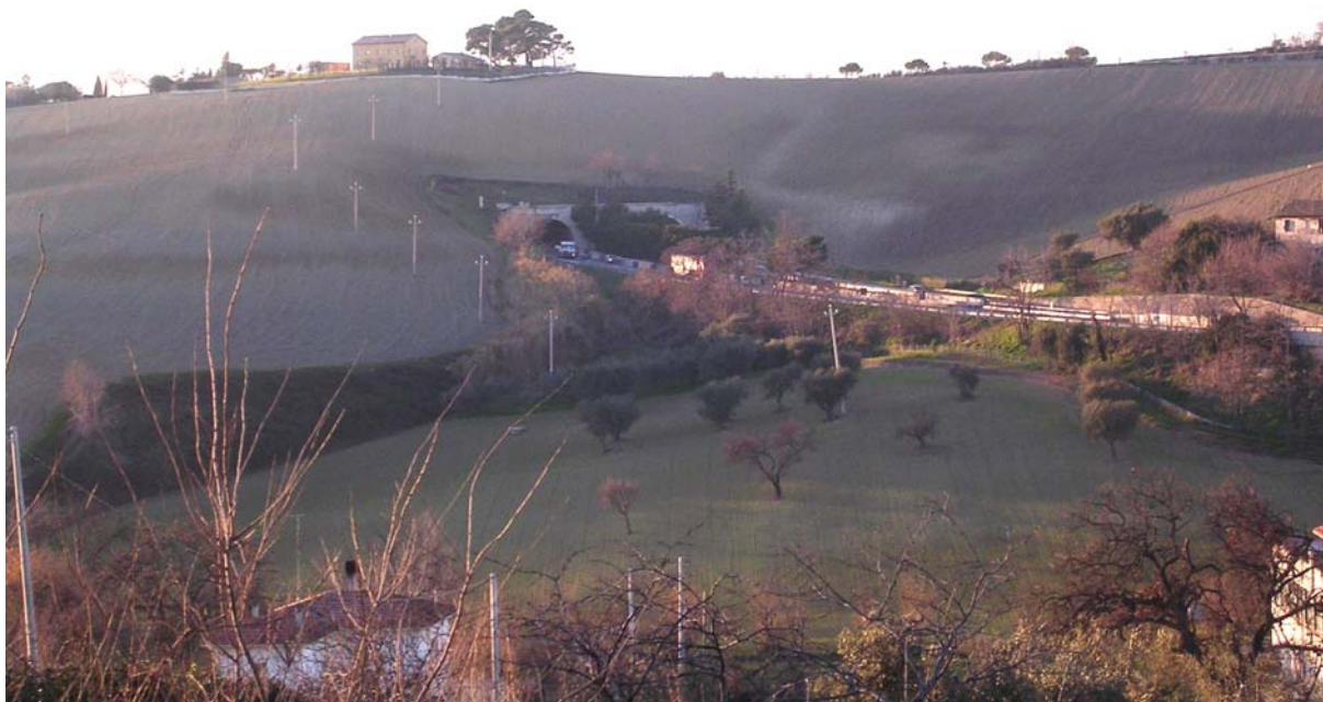
Foto 2 Vista da SW dell'imbocco sud della galleria Cavallo, il versante è caratterizzato dalla presenza di dissesti superficiali, alcune piante di ulivo risultano inclinate a testimonianza della presenza di deformazioni di tipo gravitativo.
