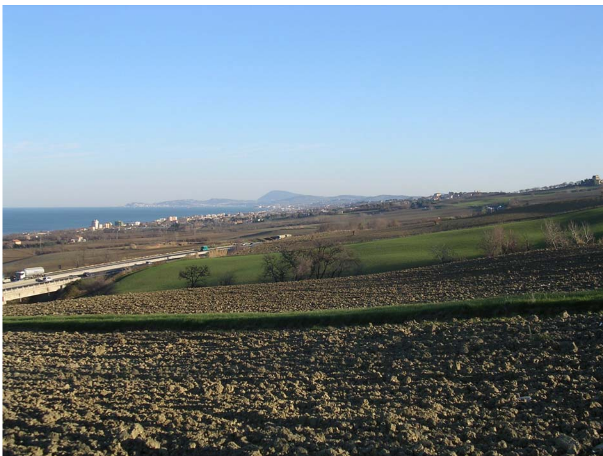
Foto 3 Vista da NW del versante che insiste sul tracciato autostradale esistente al km 198+800. Il versante è caratterizzato da ondulazioni e porzioni debolmente svuotate tipiche di aree caratterizzate da una evoluzione morfologica condizionata da dissesti di tipo gravitativo.
