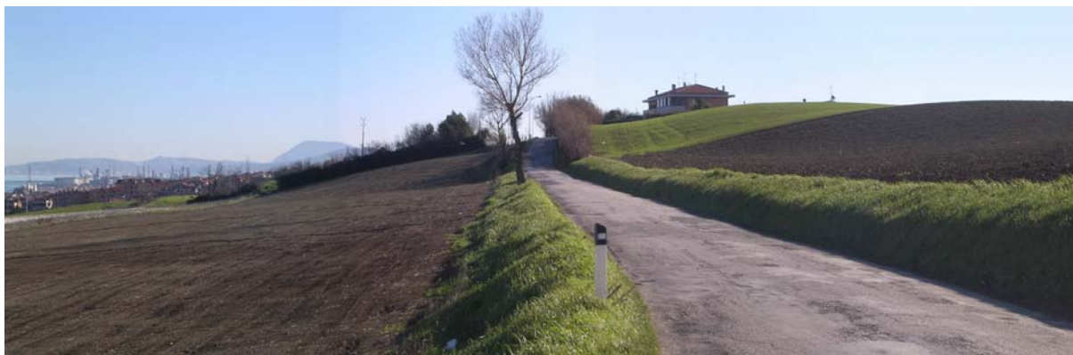
Foto 6 Vista da N del versante che insiste sul tracciato autostradale esistente al km 205+500.
