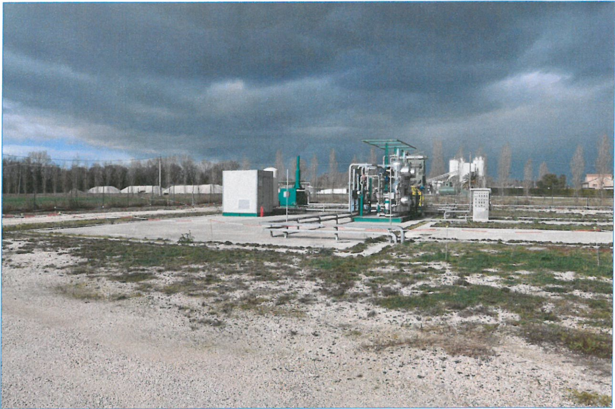
Foto 4 - L'impianto di casa Tiberi
