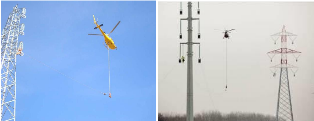
Figura 1.2.4-1 – Utilizzo dell'elicottero per stesura della fune pilota
