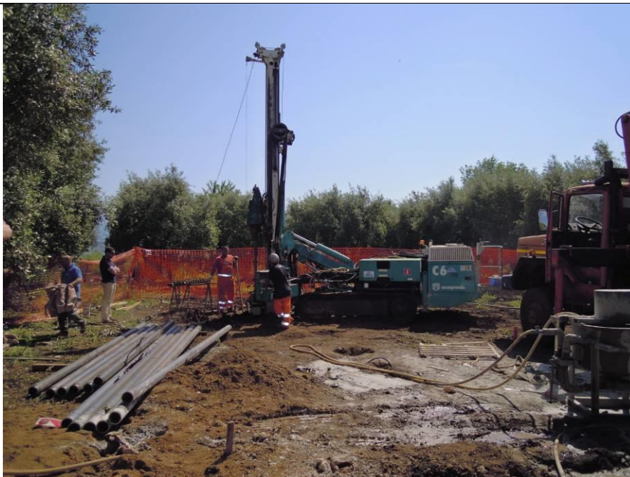
Figura 1.2.2-13 – Esempio di cantiere per la realizzazione dei micropali
