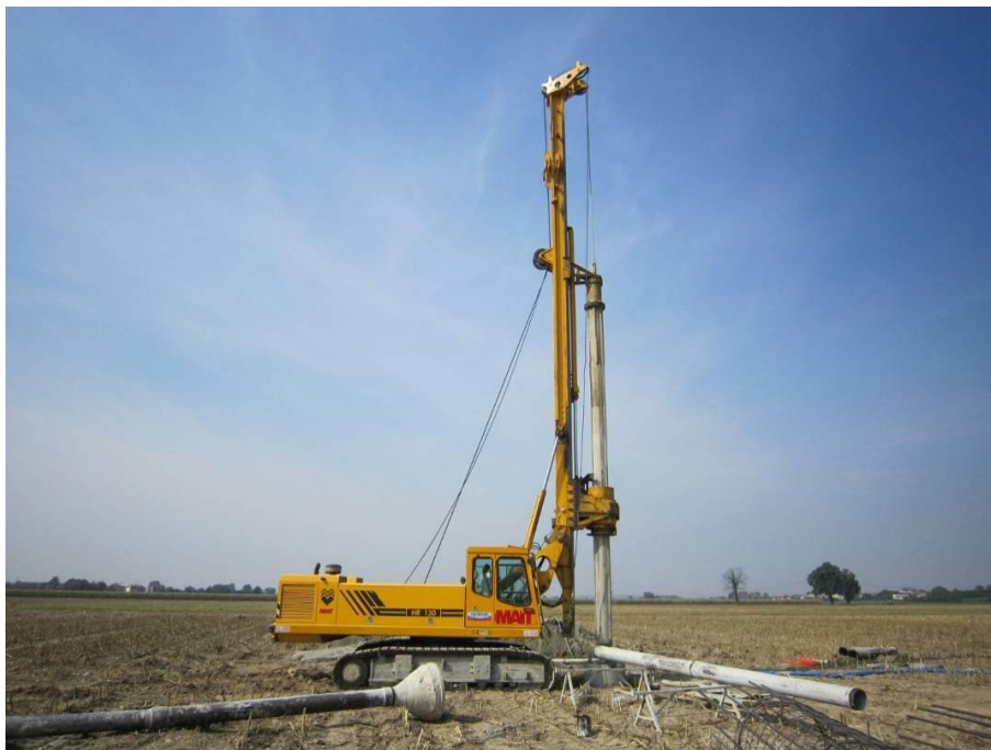
Figura 1.2.2-5 – Macchina operatrice per la realizzazione di pali trivellati
