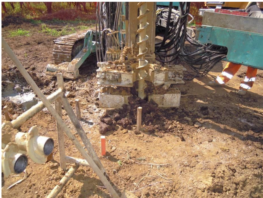
Figura 1.2.2-12 – Macchina operatrice per la realizzazione di micropali tubfix; sistema di scavo mediante trivella elicoidale
