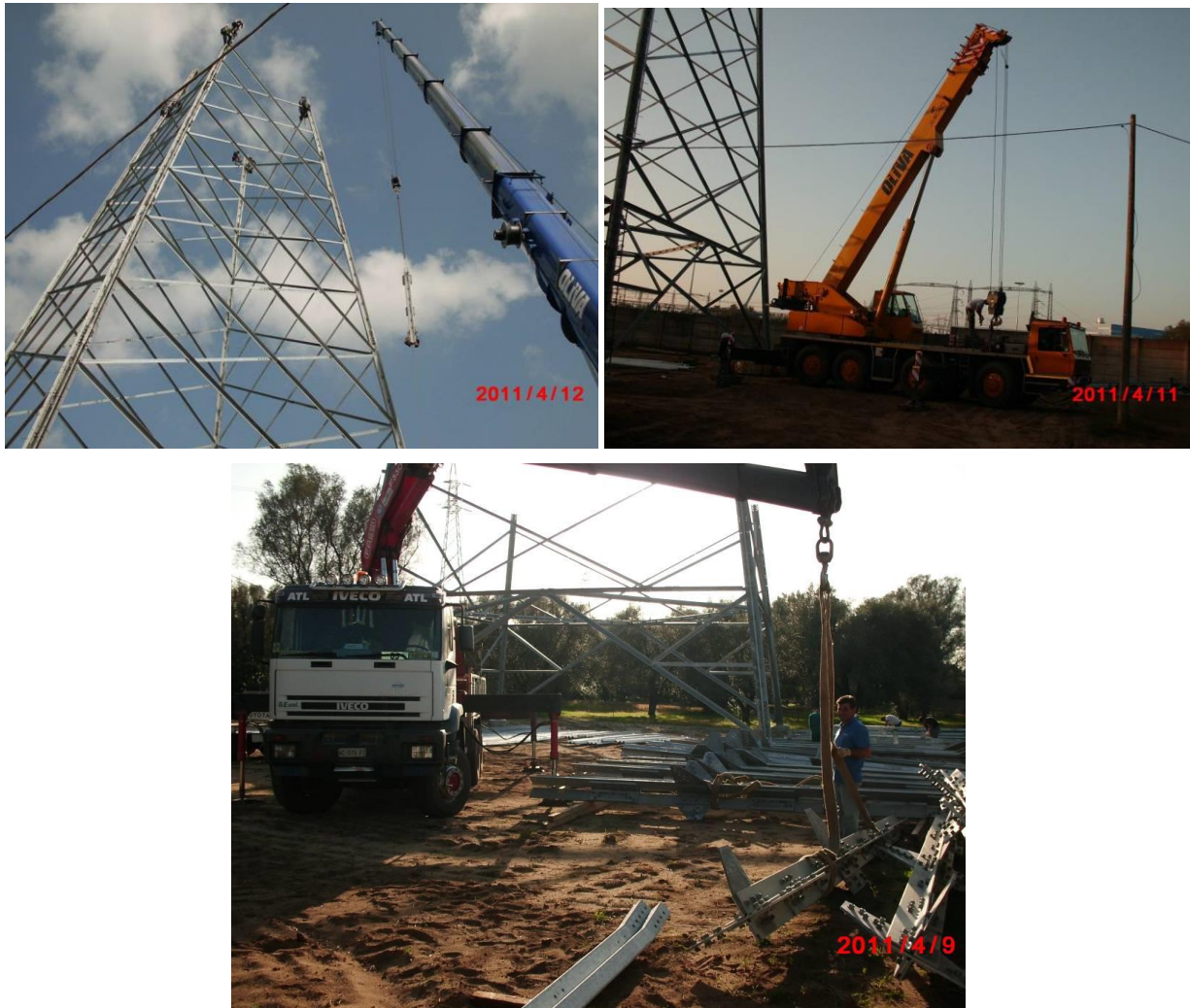
Figura 1.2.3-1 – Fasi di montaggio di un sostegno
