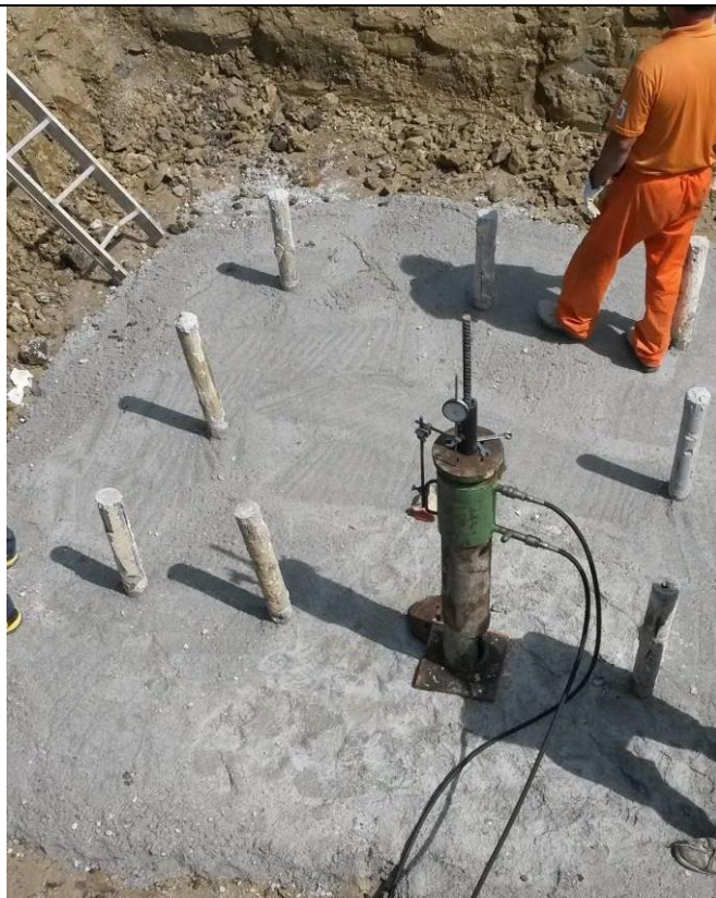
Figura 1.2.2-14 – Esempio di realizzazione dei micropali
