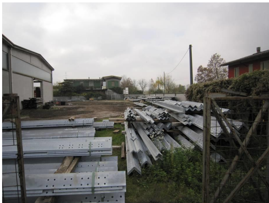
Figura 1.2.1-2 – Esempio di area centrale, deposito materiale
