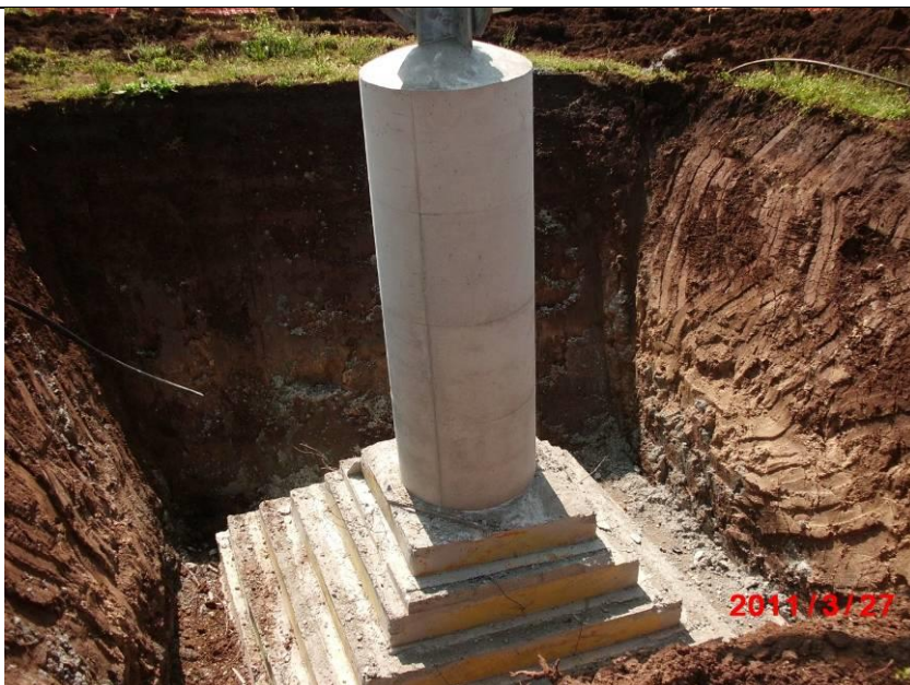
Figura 1.2.2-3 – Altri esempi di realizzazione delle fondazioni superficiali dei sostegni
