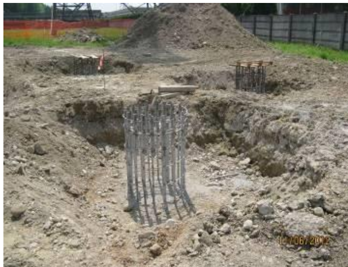
Figura 1.2.2-7 – Esempio di pali trivellati realizzati
