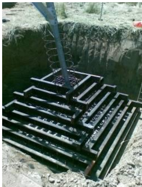
Figura 1.2.2-2 – Esempio di realizzazione di una fondazione a plinto con riseghe. Nell'immagine di sinistra di può osservare un disegno di progetto mentre nell'immagine di destra la fase di cassetatura della fondazione
