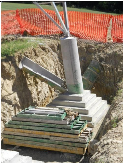
Figura 1.2.2-1 – Esempi di realizzazione delle fondazioni superficiali
