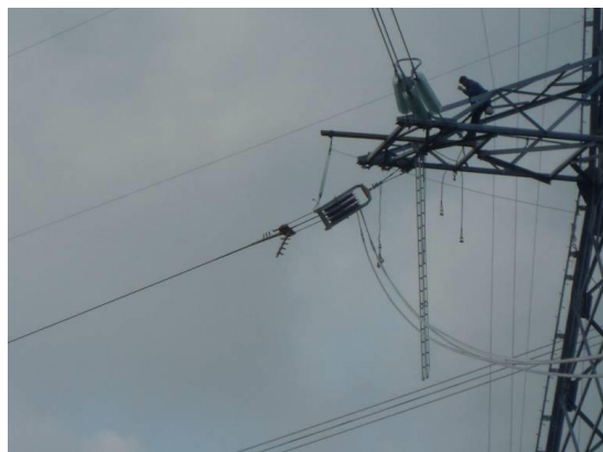
Figura 1.2.4-2 – Fasi di tesatura della linea elettrica
