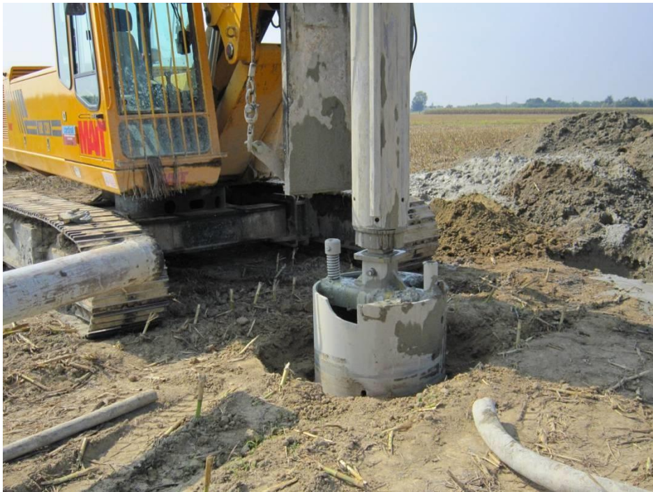
Figura 1.2.2-6 – Macchina operatrice per la realizzazione di pali trivellati. Particolare del “carotiere”
