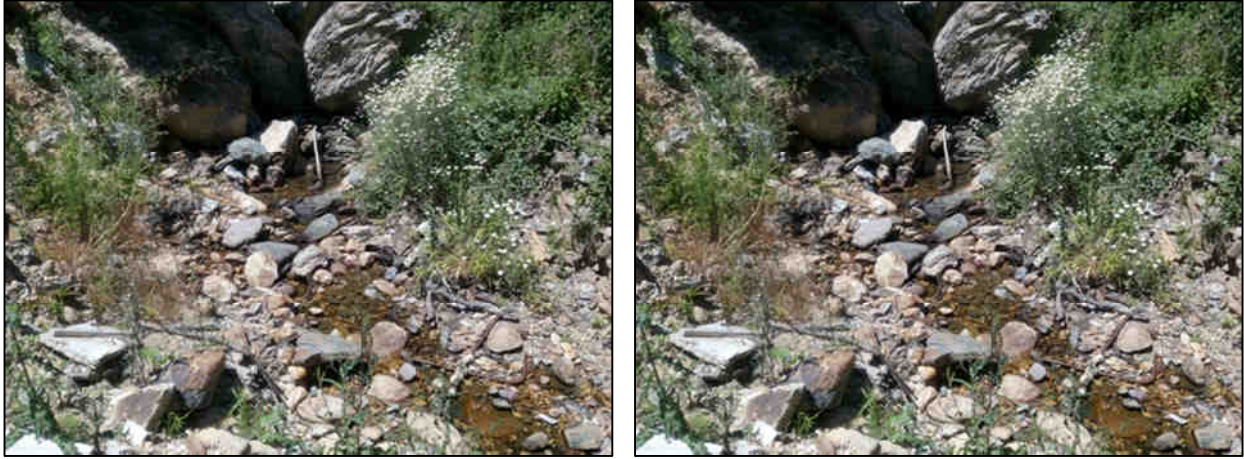
Figura 2.45 - Torrente Rilucia – ASP 05 / monte area di cantiere
