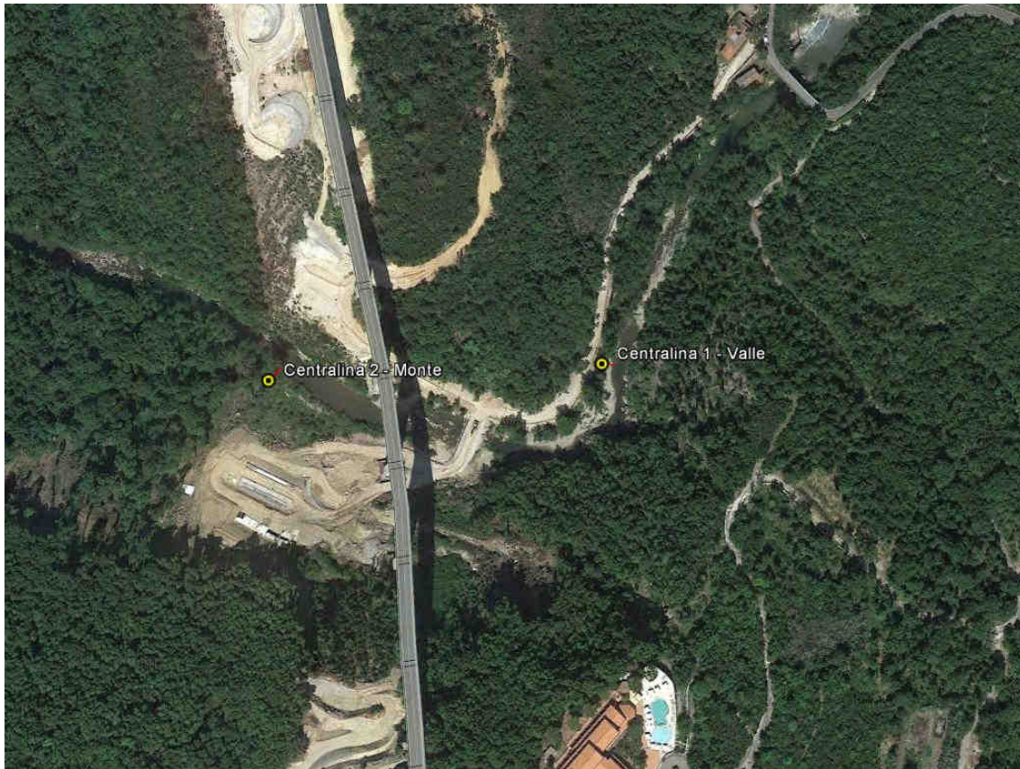
Figura 2.39 – Vista globale del sito di indagine
