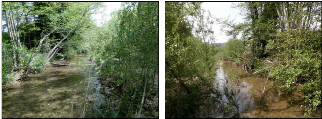
Figura 2.46 - Torrente Lanzo – ASP 04 / valle area di cantiere
