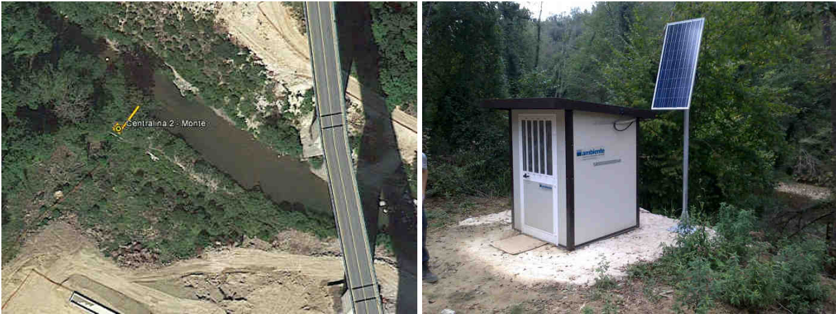
Figura 2.41 – Centralina 2 – Monte ed indicazione del cavidotto di indagine (43° 4'38.75"N - 11°17'44.29"E)
