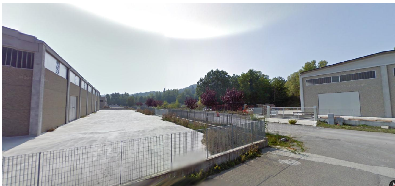
Figura 167 – Vista dall'area produttiva in prossimità del Piazzale Sicurezza Imbocco Serravalle Sud (IN1J0) verso la macchia di bosco oggetto di vincolo paesaggistico (Fonte Google Streetview ottobre 2011)
