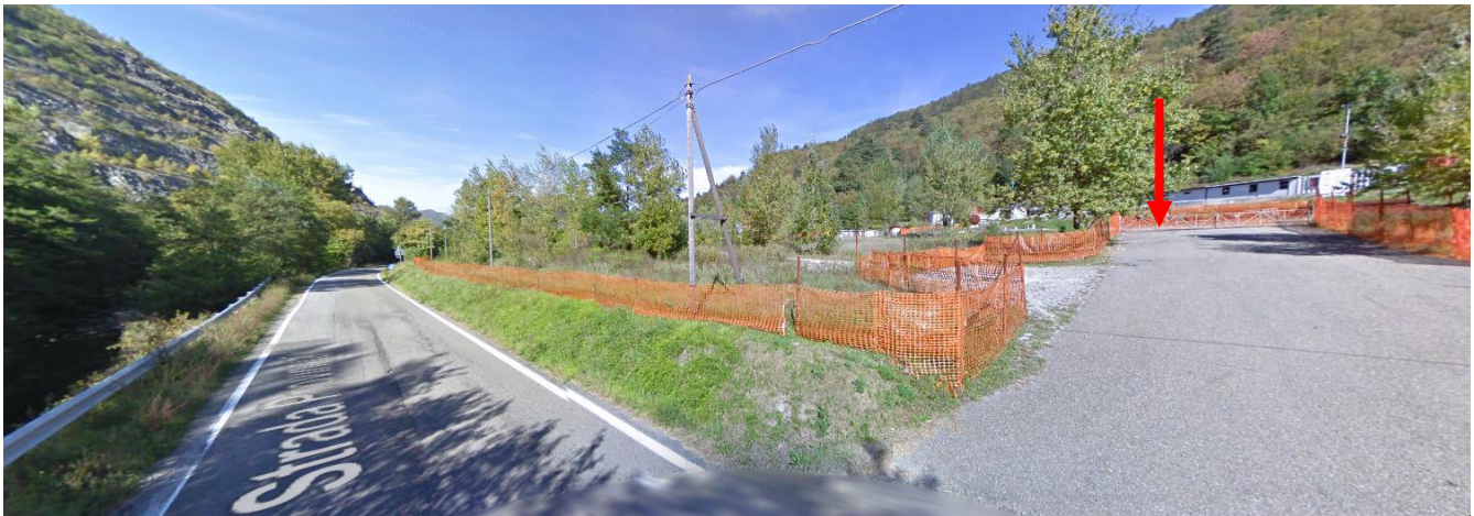
Figura 148 – Vista dalla SP160 della area Imbocco Val Lemme (Fonte Google Streetview ottobre 2011). La freccia rossa indica l'area dell'imbocco Val Lemme.
