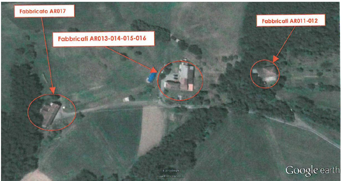
Figura 138 – Localizzazione degli edifici oggetto di demolizione presso il Cantiere Fresa Pk 27+450 Radimero (GA1U)
