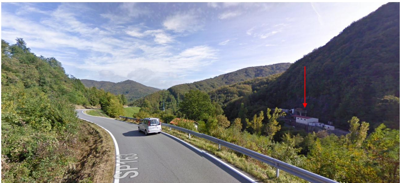
Figura 157 – Vista dalla SP 163 della area Imbocco Castagnola, indicata in rosso (Fonte Google Streetview ottobre 2011)
