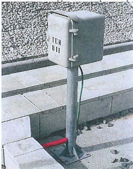
**Figura 25 – Dispositivo Tch dentro al quale è custodita e bloccata la chiave FS**
