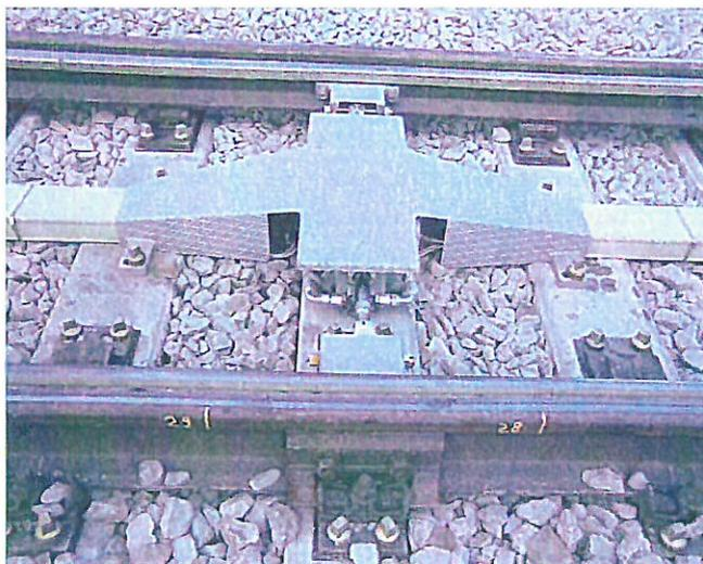
**Figura 18 – Copertura di protezione dell’Attuatore intermedio Telaio aghi riscalzabile**
