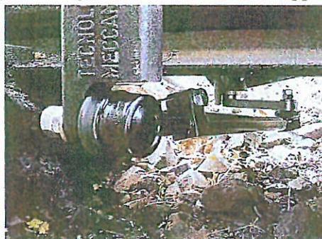
**Figura 24 – Tirante a teste snodate**
