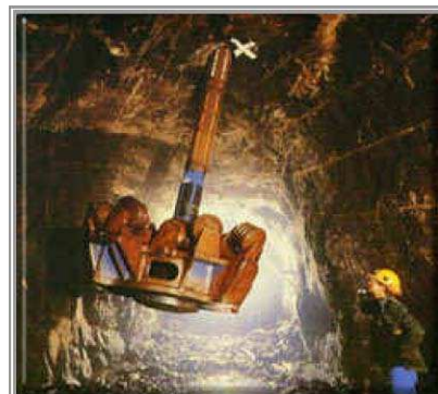
La foto viene riportata a solo titolo di esempio; si vede che all'interno di un cunicolo, è stato effettuato il montaggio della testa alesante all'asta di trascinamento.
