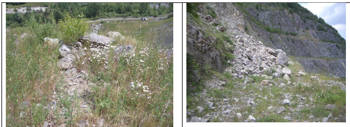
Figura 1 - sinistra: segni di impatto sul detrito di un gradone; destra: punti di arresto dei blocchi presso ed accumulo di una piccola frana.
