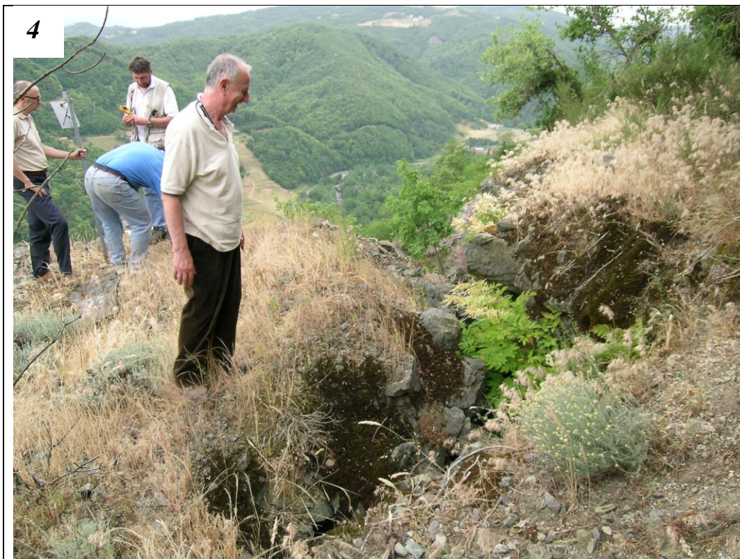
Figura 21: trench presenti nella parte alta dell'accumulo (1); sperone di metabasalti con immersione a reggipoggio (2); frattura aperta 30-40 cm al coronamento (3); prosecuzione della stessa (apertura di circa 60 cm) in prossimità della mira ottica n. 5 (4).
