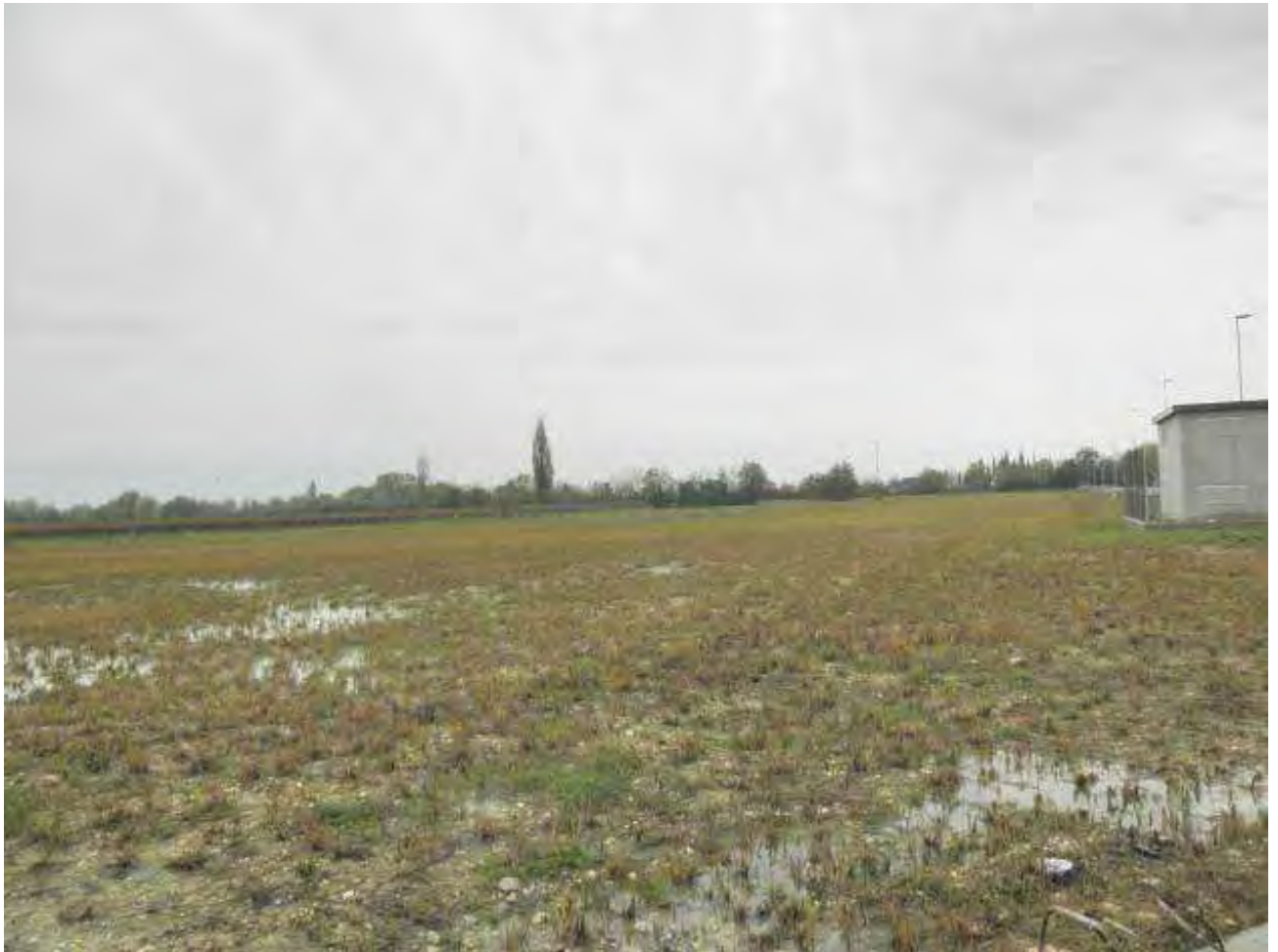
Vista dell'area destinata al cantiere operativo.
