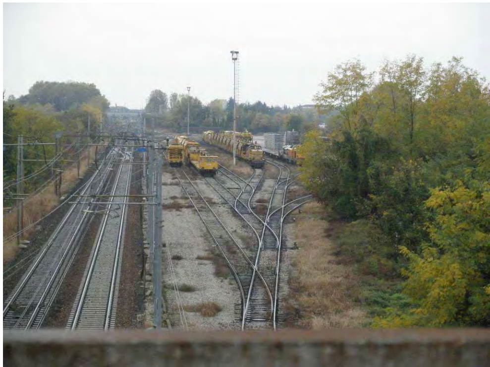
Vista dell'area destinata al cantiere di armamento, ora facente parte di uno scalo ferroviario, dal cavalcavia della Strada Statale n. 14 della Venezia Giulia.
