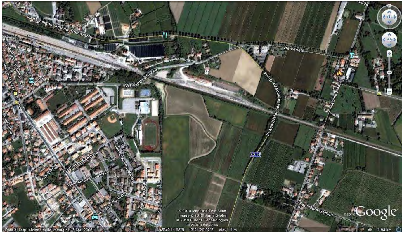
Vista aerea dell'area destinata al cantiere di armamento (Ortofoto da Google Earth).
