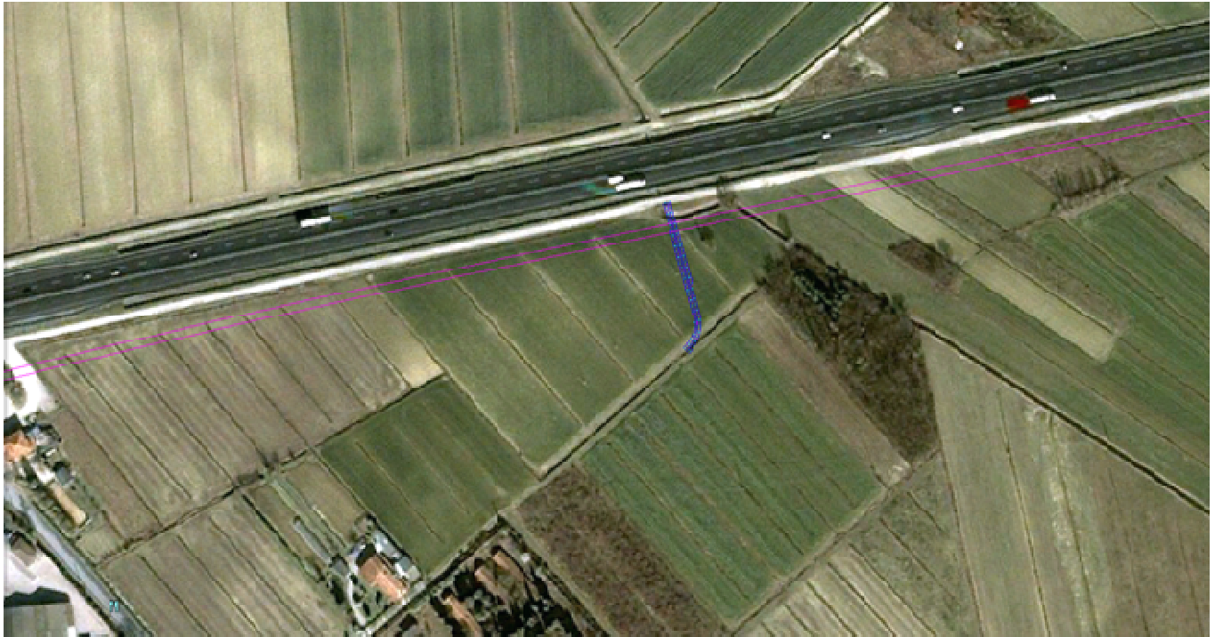
Figura 5.5.1 Deviazione provvisoria canale Confine
