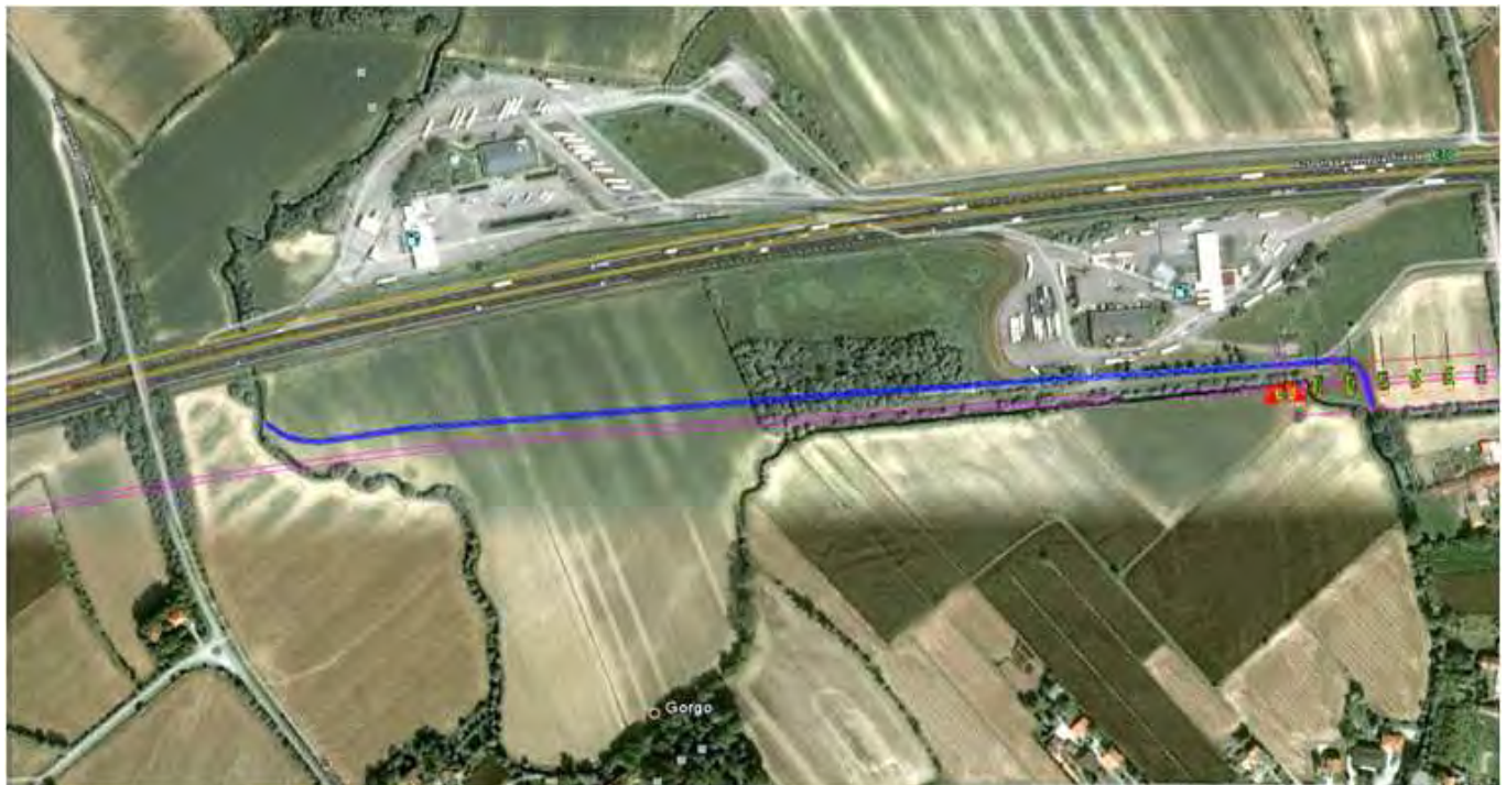
Figura 5.1.1 deviazione provvisoria canale Roggia Lugugnana .
