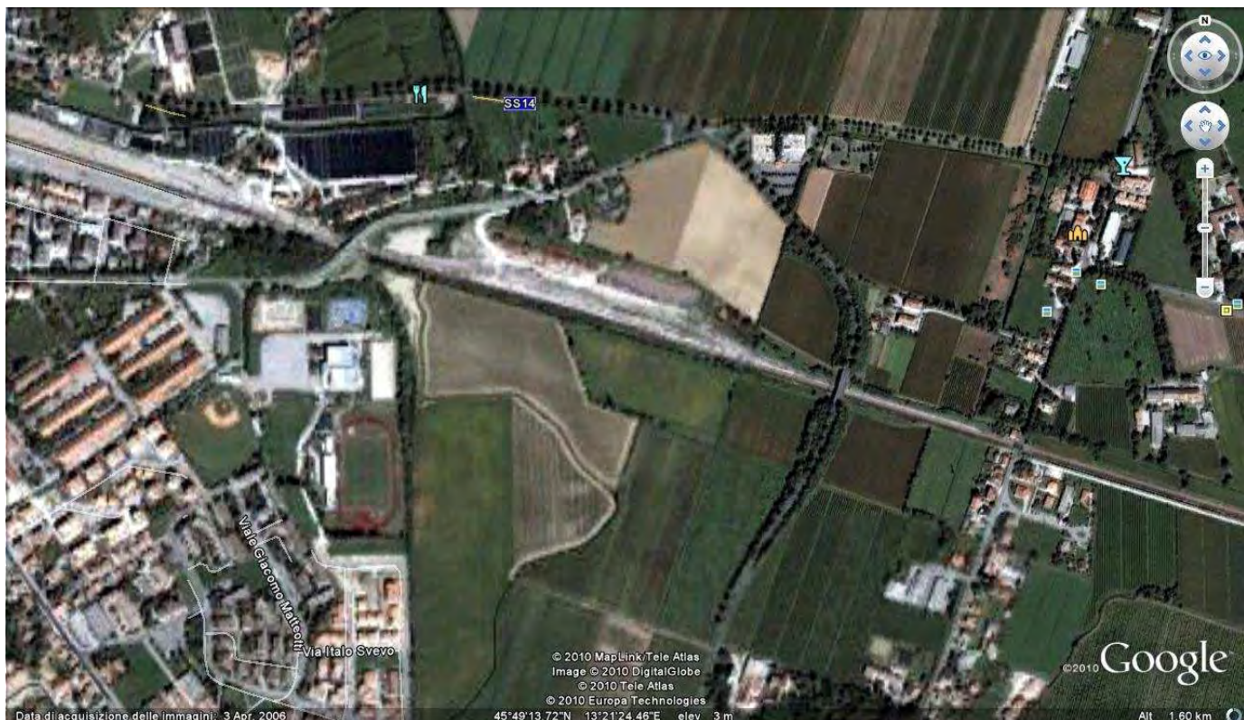
Vista aerea dell'area destinata al cantiere base, a sud della linea ferroviaria (Ortofoto da Google Earth)
