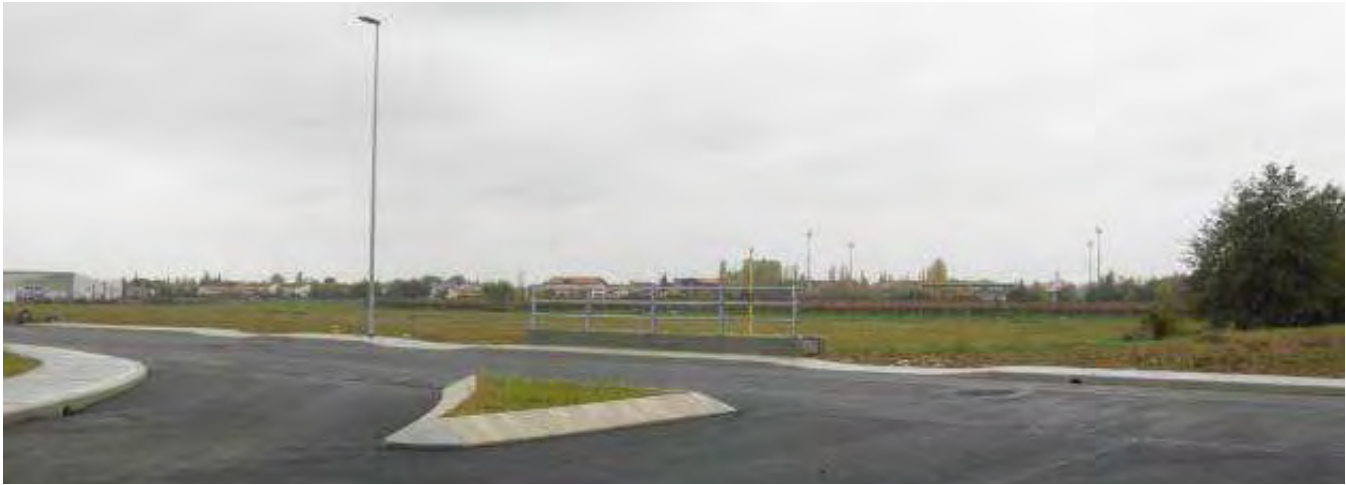
Vista dell'area destinata al cantiere operativo, con le recenti opere di urbanizzazione.
