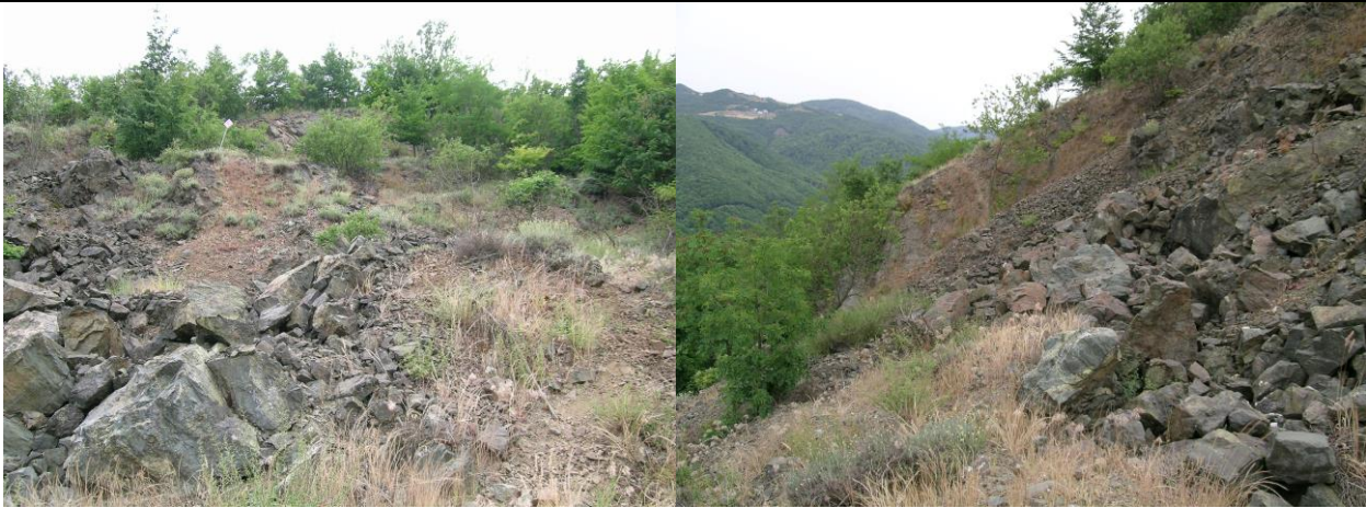
3-4- In sinistra dettaglio della foto precedente con l'accumulo ripreso da valle, in prossimità del piede. Nella foto di destra il fianco meridionale del coronamento.
