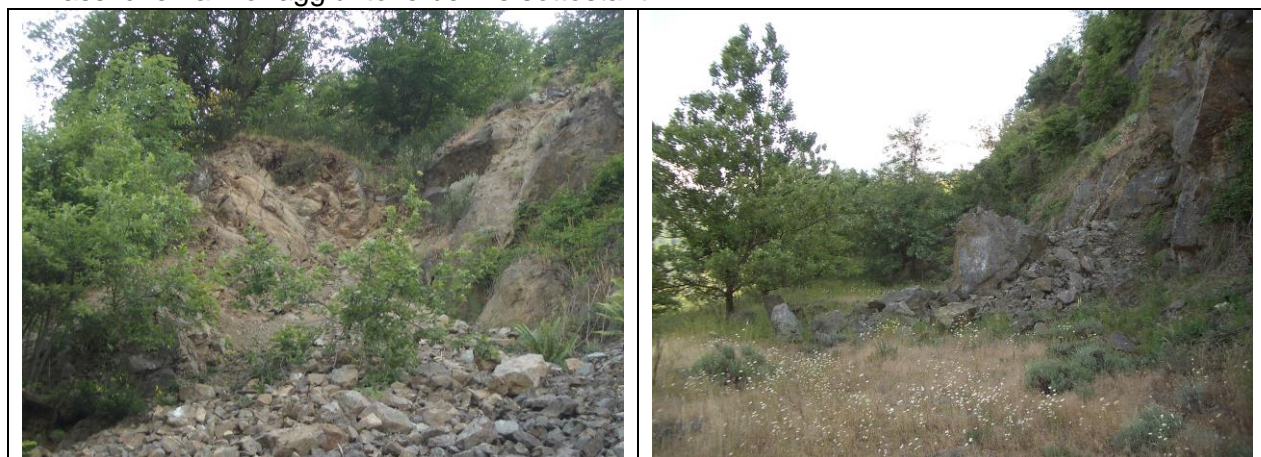
Figura 14: esempio tipico di frana di crollo.
