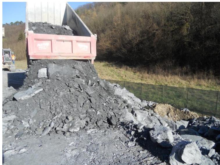
Durante le operazioni di formazione dello strato, sono stati tolti i blocchi più grossi in modo da permettere una idonea compattazione del materiale.
