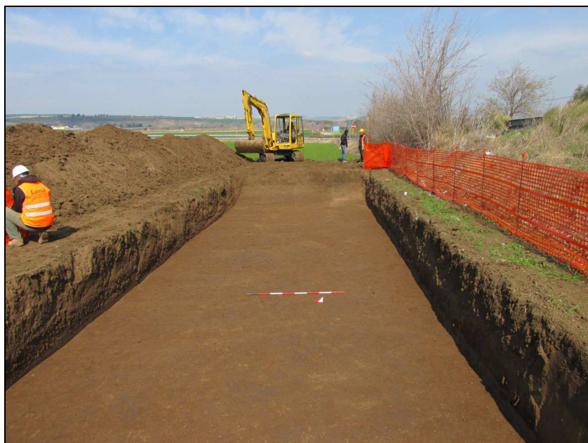
Figura 18 – La trincea 1 in NV05 a fine scavo (profondità 1 m).
