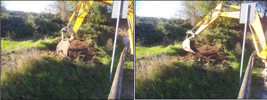
Pozzetto esplorativo S7
