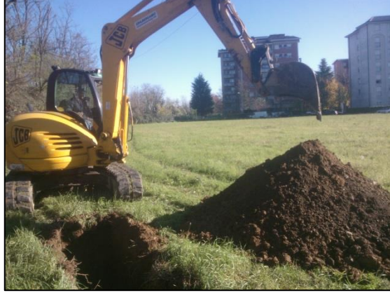
Pozzetto esplorativo S4
