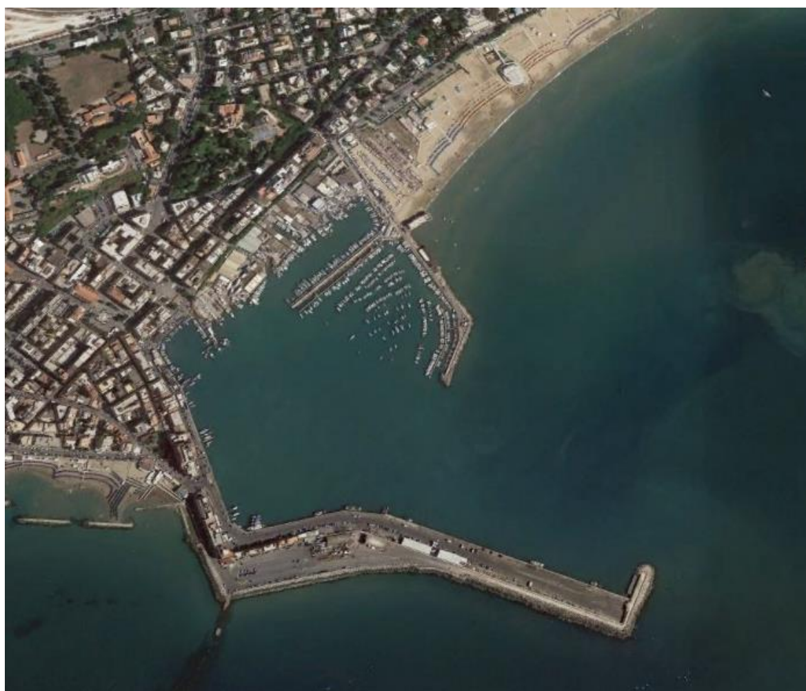
Figura 1. Vista aerea del porto turistico di Anzio (RM) Stato attuale
