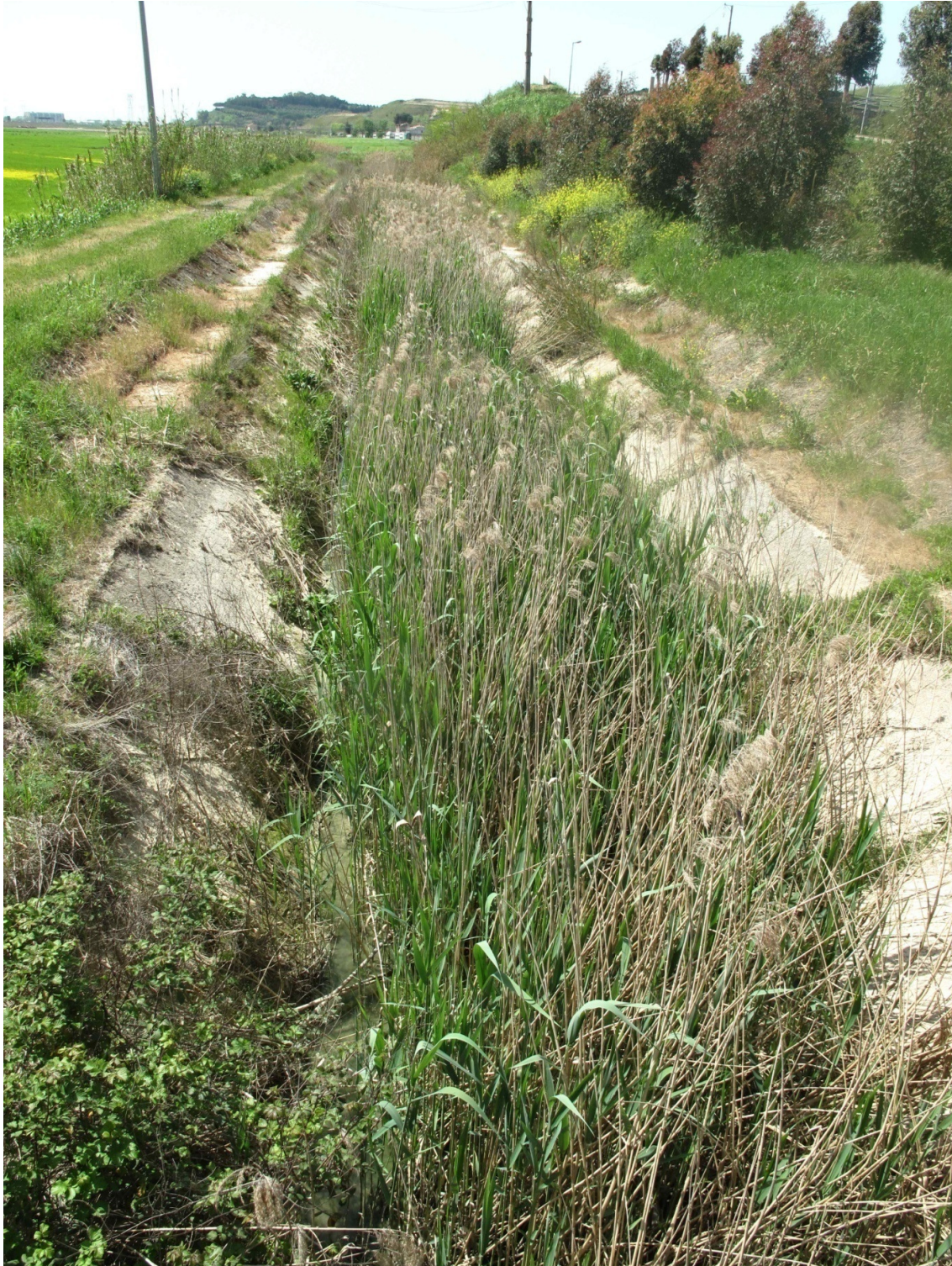
Foto 6 - Canale posto tra la ferrovia e l'area di interesse
