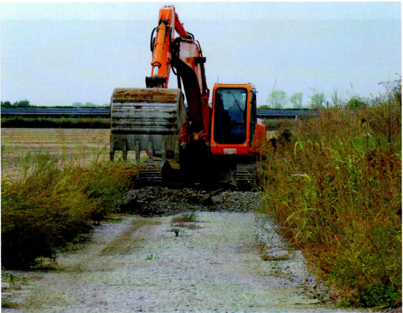
Foto 4 sostegno n. 48 rimozione del materiale posto come fondo per accedere al cantiere 12/10/15
