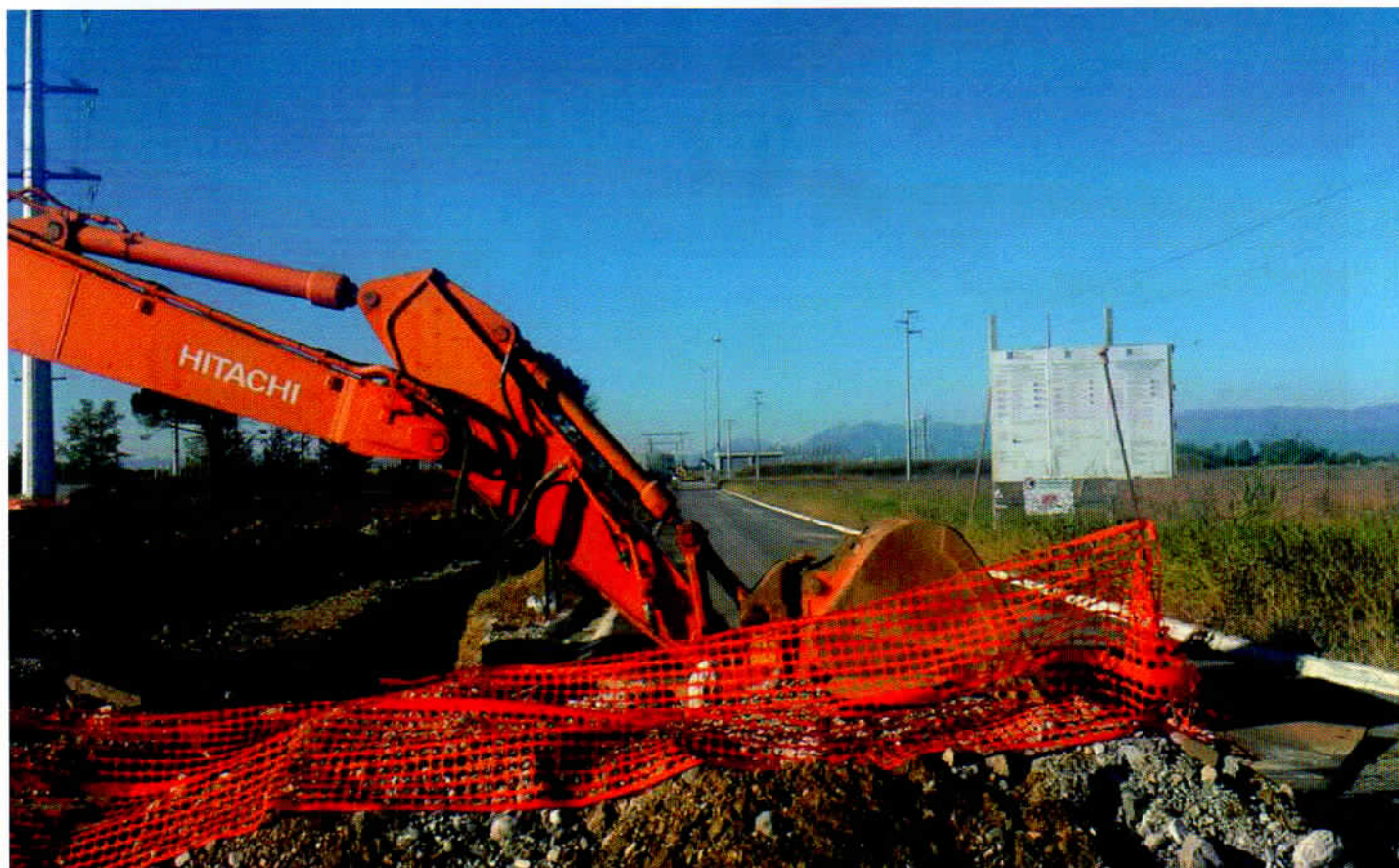
Foto 2 esecuzione di uno scavo parallelo alla via di accesso alla centrale 20/10/15
