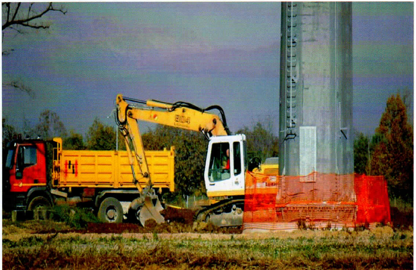
Foto 9 sostegno n. 36 con escavatore in fase di ritombamento del cantiere l'11/11/15
