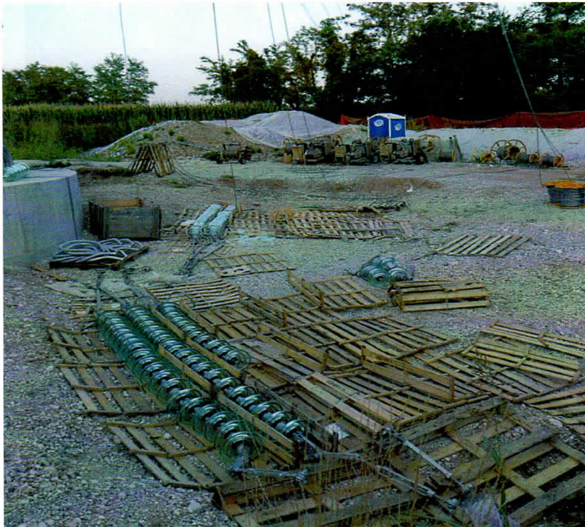
Foto n. 6 sostegno n. 43 con i rimanenti isolatori temprati da collocare il 06/08/15
