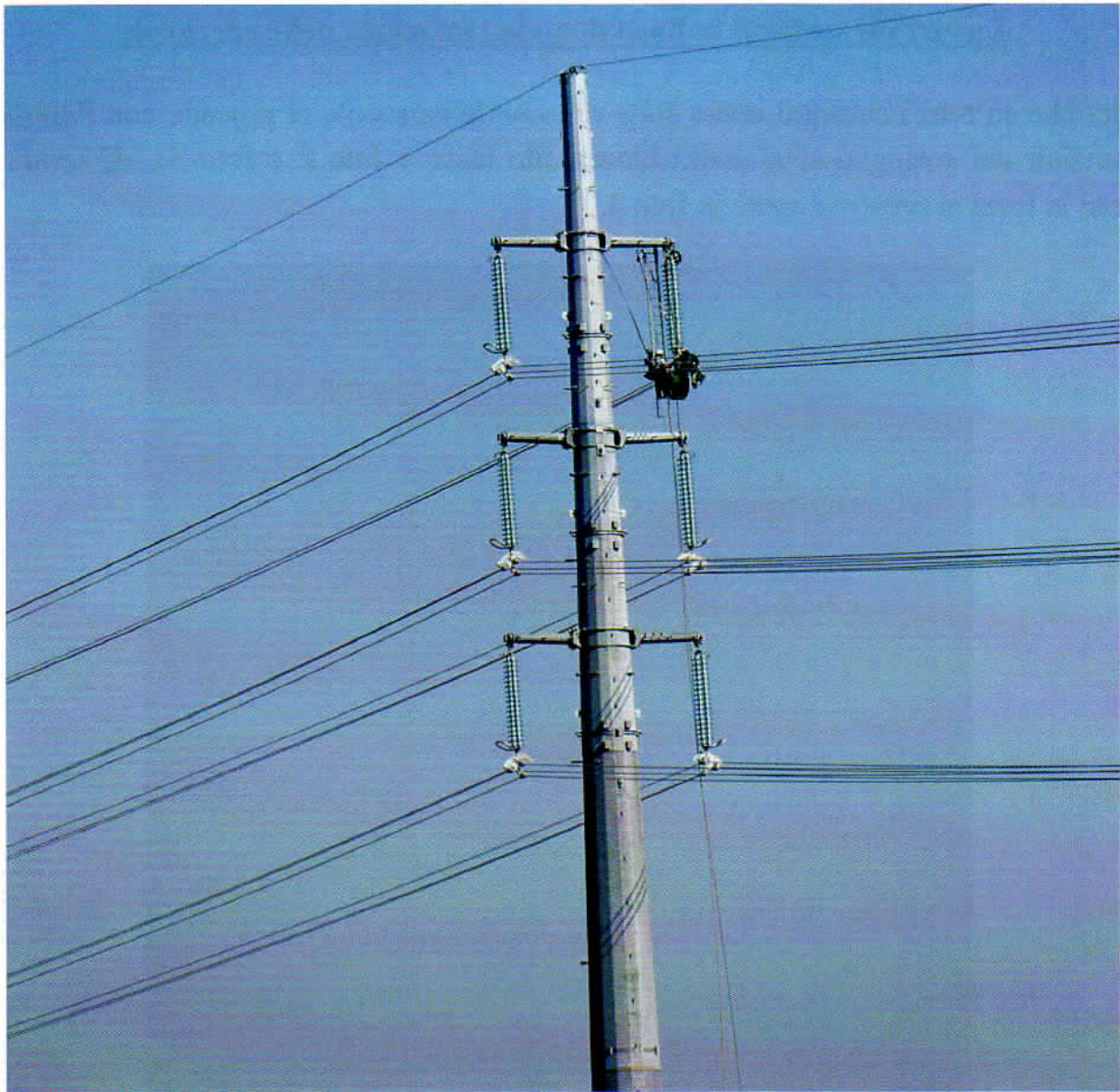
Foto 4 sul sostegno n. 38 personale al lavoro per rimuovere l'ultima carrucola sul lato destro il 10/08/15
