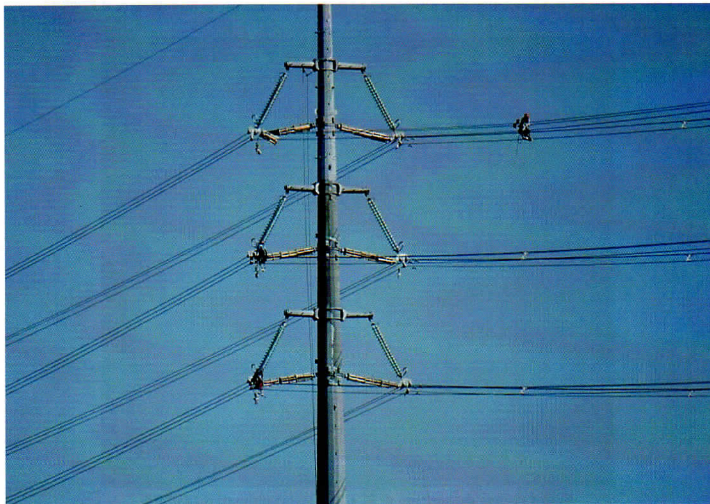
Foto 2 sostegno n. 39 con addetti in fase di posizionamento dei distanziali il 29/08/15
