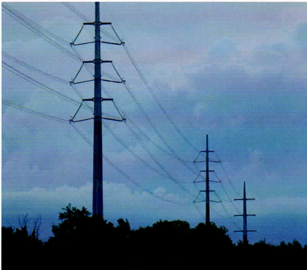
Foto 4 visione dei sostegni n. 32 e 31 a lavori ultimati il 18/08/15
