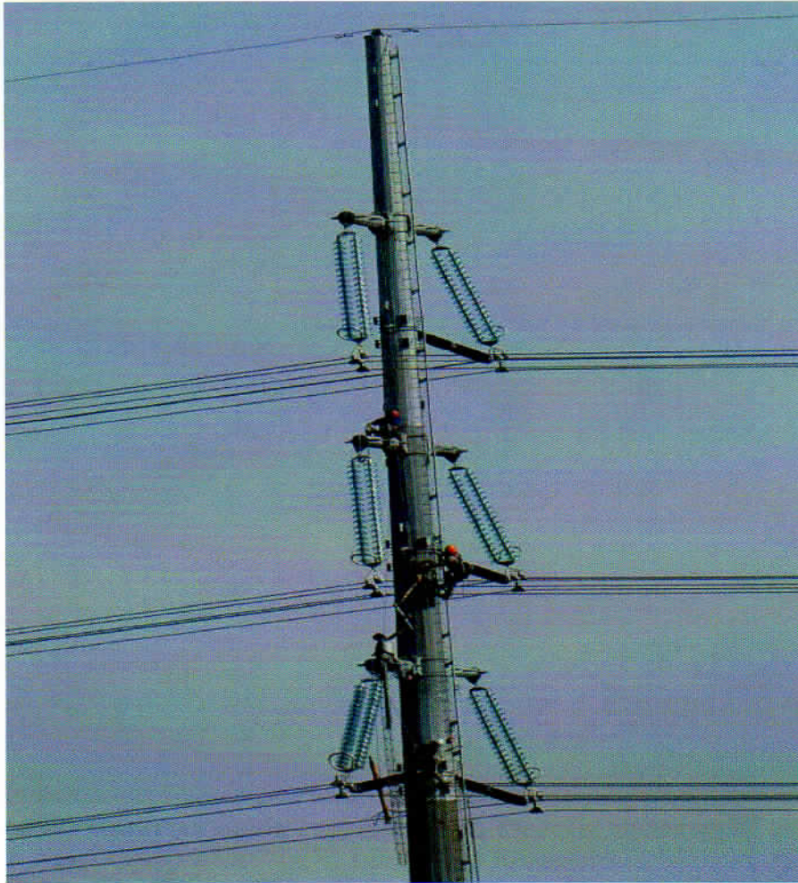
Foto 1 sostegno n. 31 personale durante le operazioni di fissaggio dei distanziali il 12/08/15
