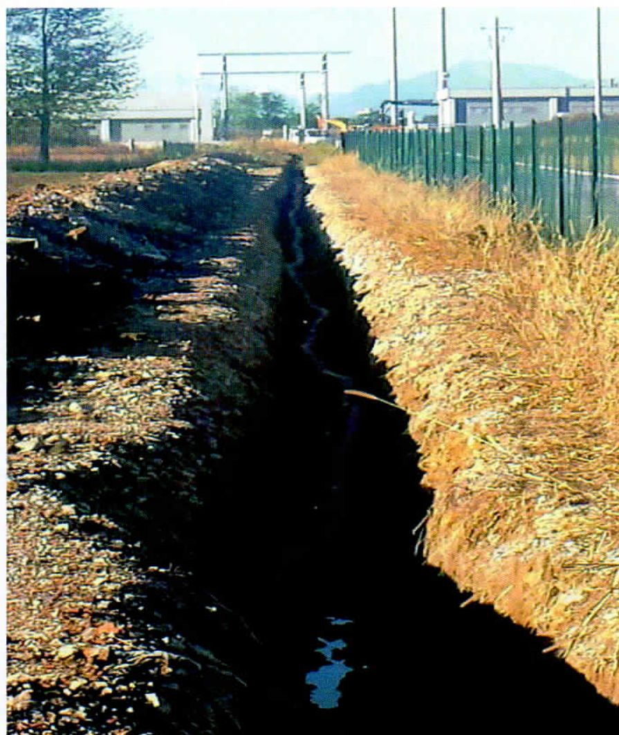
Foto 3 scavo e posa di un corrugato porta cavi in uscita dalla nuova stazione Udine sud il 20/10/15
