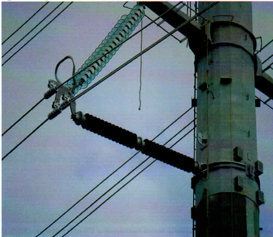
Foto 2 sostegno n. 32 visione ravvicinata del fissaggio dei distanziali il 17/08/15
