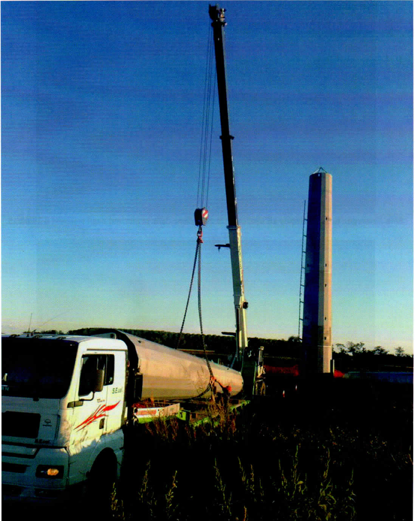
Foto 1 cantiere sostegno n. 54 carico e rimozione del tubolare il 08/09/2015
