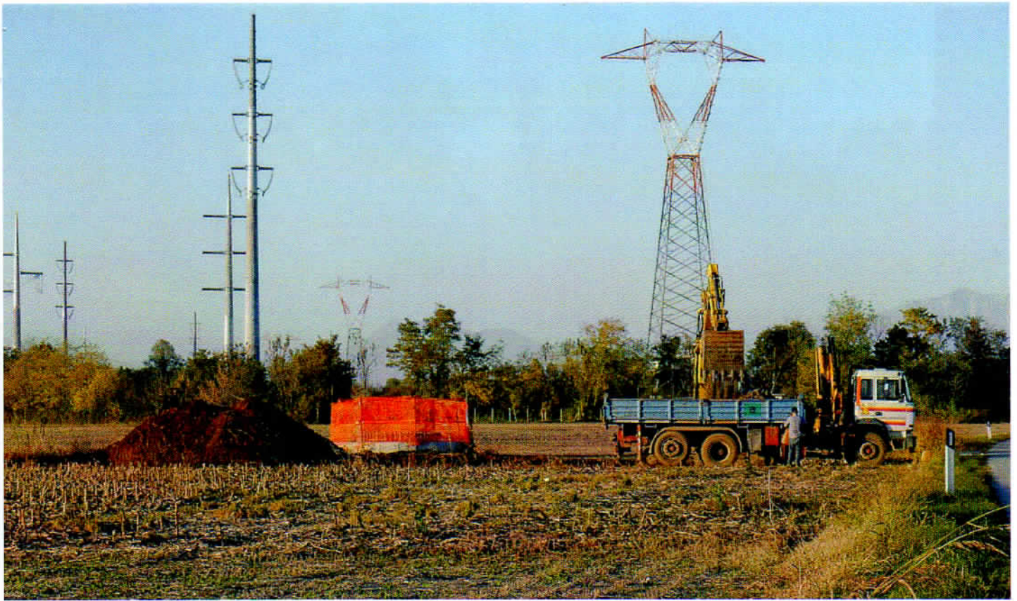
Foto 6 fondazione n. 16 rimozione del materiale posto come fondo per accedere al cantiere e successivo ritombamento in assenza di sostegno il 03/11/15
