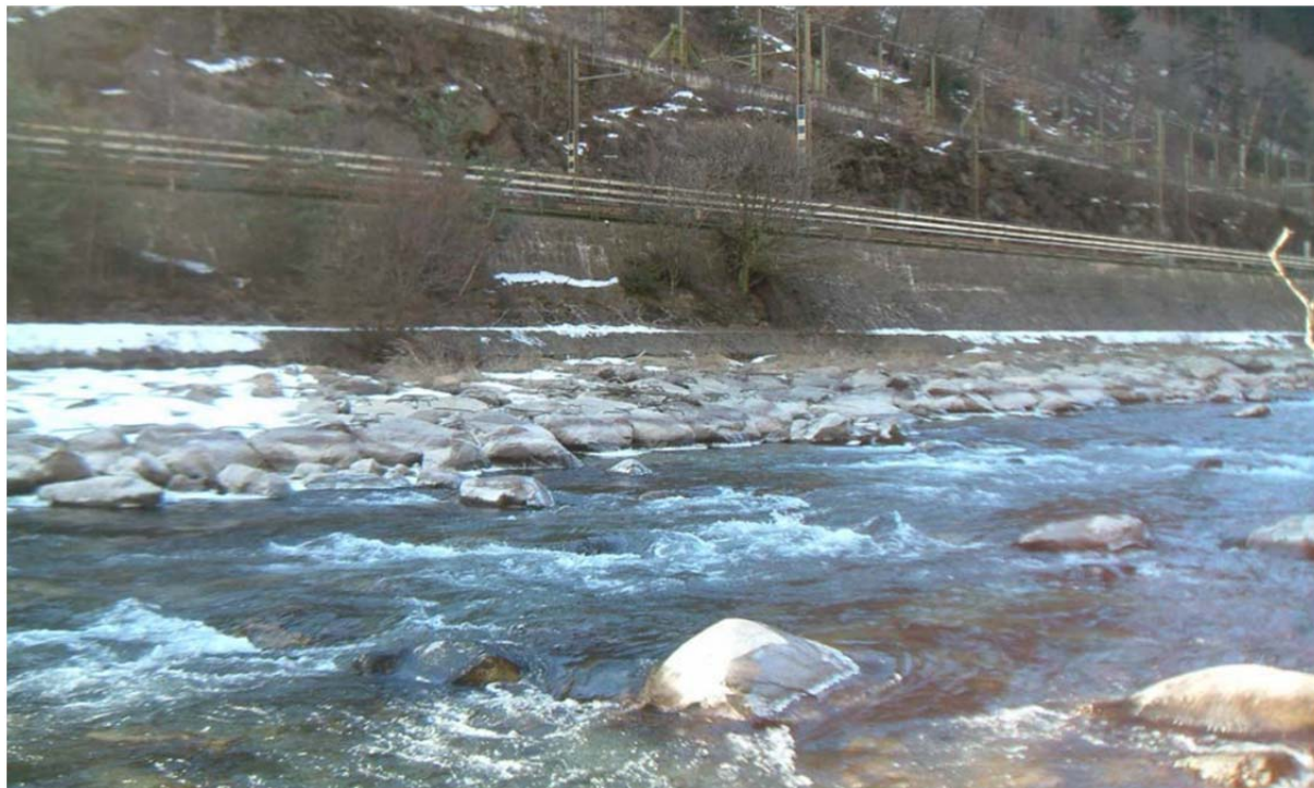
Figura 1: Opere di consolidamento del rilevato ferroviario a monte della confluenza con il Rio Mara
