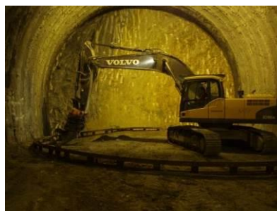
Abbildung 38 – Maschine zum Einbau von Lehrgerüsten im Tunnel
