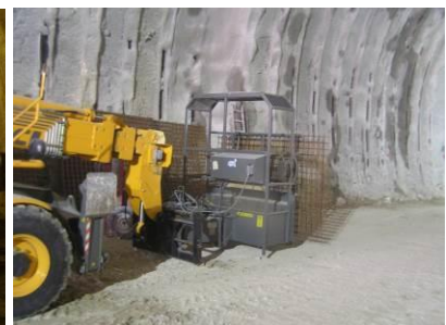
Illustrazione 38 – Attrezzatura per la posa delle centine in galleria
