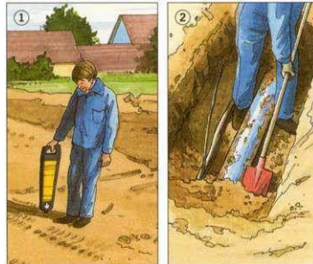
Illustrazione 86 – Linee interrato
