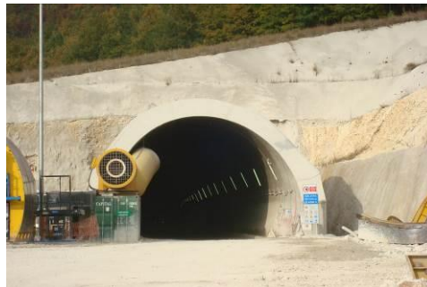
Illustrazione 18 – Elettroventilatore
