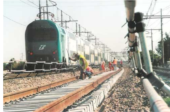
Illustrazione 31 - Protezione dei cantieri su linee ferroviarie in esercizio
