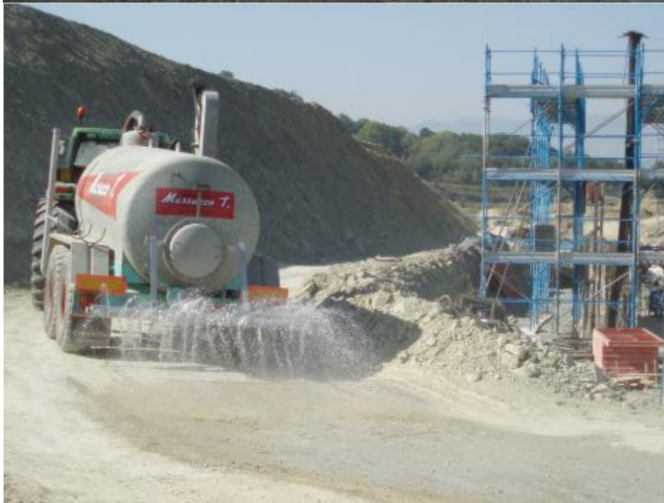
Foto 35 a – Sistema di bagnatura delle piste e delle strade di cantiere con camion con cisterna e/o autobotte trainata da trattore
