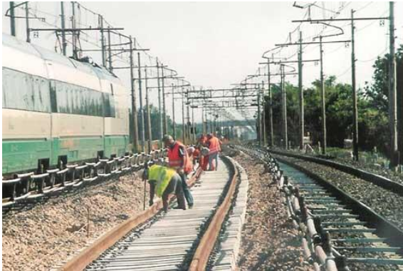
Abbildung 31- Sicherung von Baustellen an in Betrieb befindlichen Bahnstrecken
