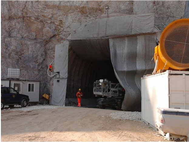
Abdeckplane an der Einfahrt, vor der Sprengung
