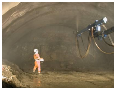
Illustrazione 15 – Esecuzione spritzbeton
