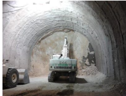
Illustrazione 14 – Disgaggio con martellone
