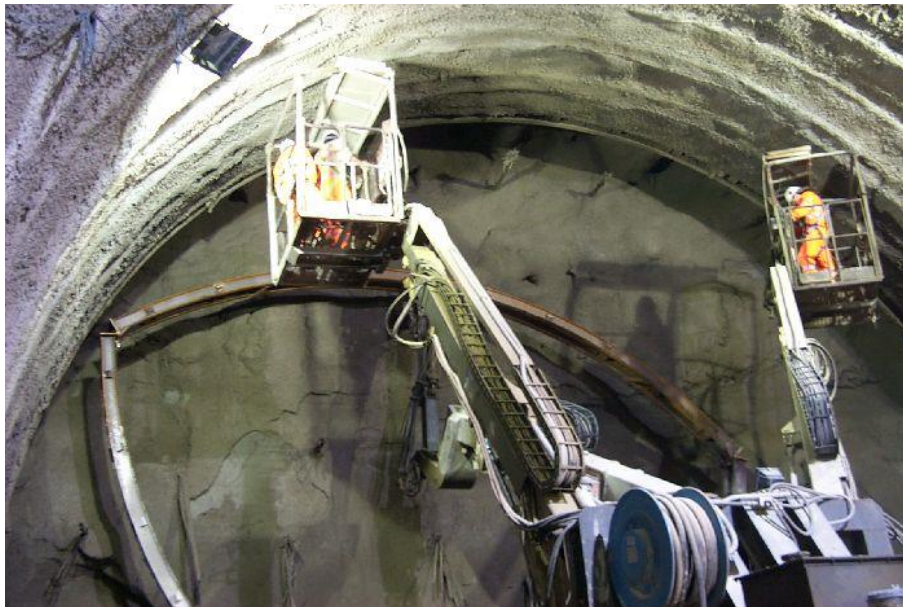
Abbildung 19 – Lehrgerüste Einbaugerät
