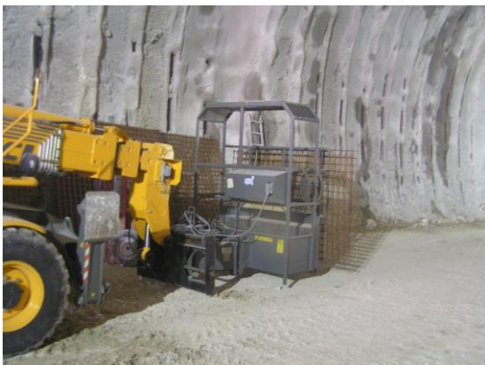
Abbildung 20 – Einbau von Baustahlmatten
