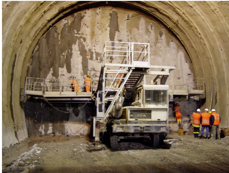
Abbildung 5 – Vortrieb mit Sprengstoff
