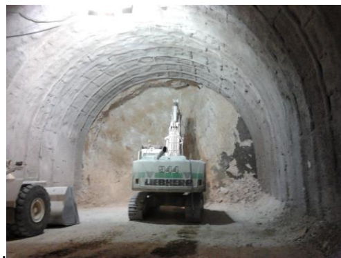
Illustrazione 9 – Disgaggio di sicurezza
