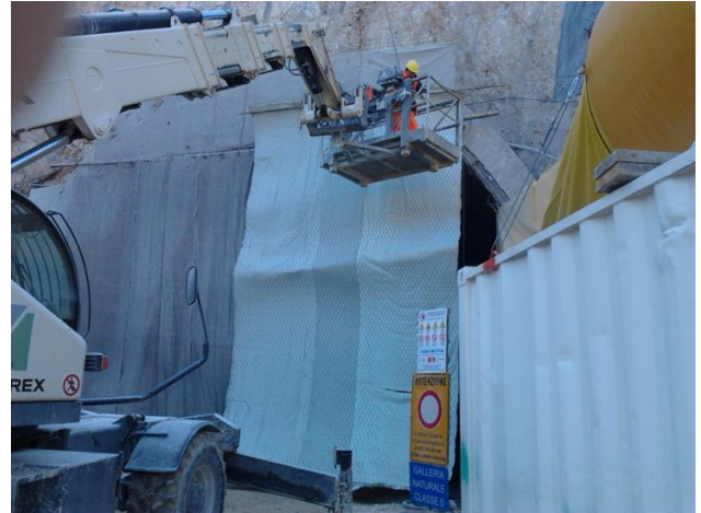
Telo di chiusura dell'imbocco prima del brillamento
