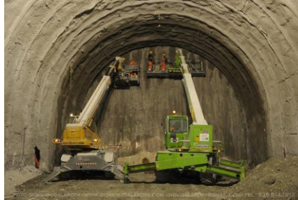
Illustrazione 2 – Perforazione fori di volata
