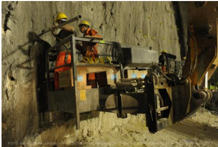
Abbildung 2 – Bohrung der Sprenglöcher
