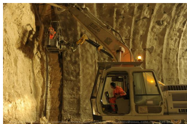
Illustrazione 20 – Posa reti elettrosaldate
