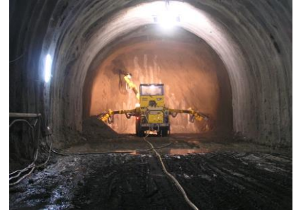
Illustrazione 2 – Perforazione fori di volata
