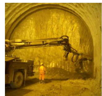
Illustrazione 15 – Esecuzione spritzbeton
