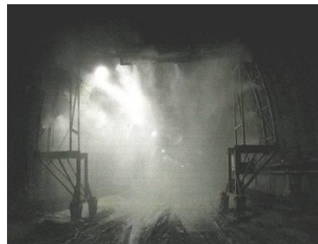
Illustrazione 33 – Nebulizzazione ad acqua
