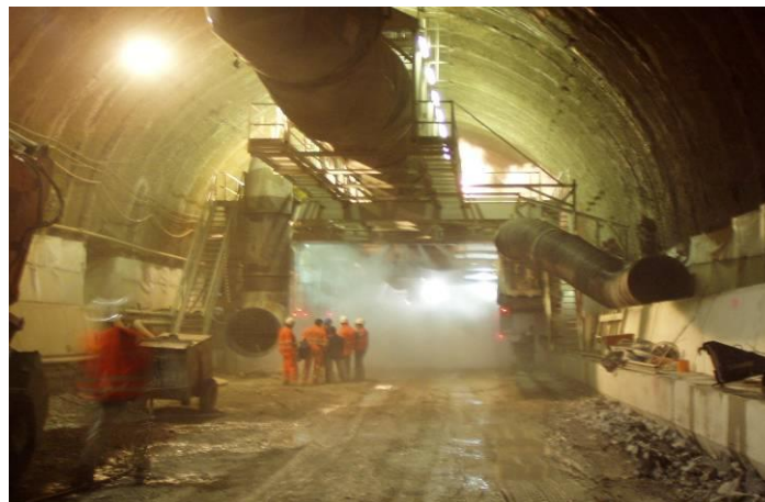
Illustrazione 34 – Luft-Wasser Vernebelung
