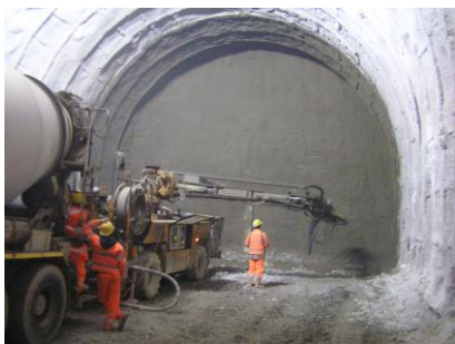
Abbildung 15 – Einbau von Spritzbeton
