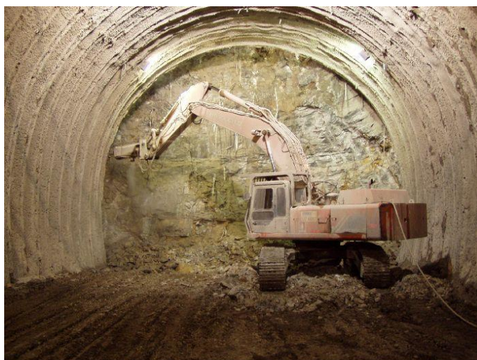
Abbildung 1 – Vortrieb mit Abbruchhammer
