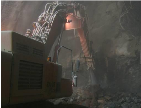
Abbildung 36 – Kopf des Hammers
