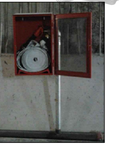
IDRANTE UNI 45 - INSTALLAZIONE TIPO IN GALLERIA
