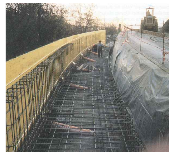
LO SCAVO DEVE ESSERE PROTETTO DALLA PIOGGIA CON UN TELO IMPERMEABILE PER GARANTIRE LA STABILITÀ IN QUALSIASI CONDIZIONE. DIE GRUBE MUSS MIT EINER UNDRÜHLÄSSIGEN PLANE VOR REGEN GESCHÜTZT WERDEN, UM DEREN STABILITÄT BEI ALLEN WITTERUNGSBEDINGUNGEN ZU GEWÄHRLEISTEN.
