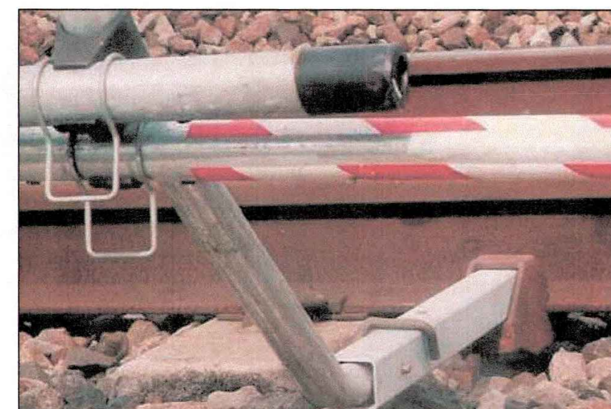
FOTO 02 Vista della scarpa di ancoraggio fissata al binario, del braccio e del montante telescopico
