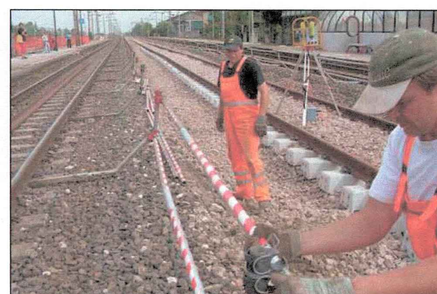
FOTO 07 Montaggio corrente superiore
