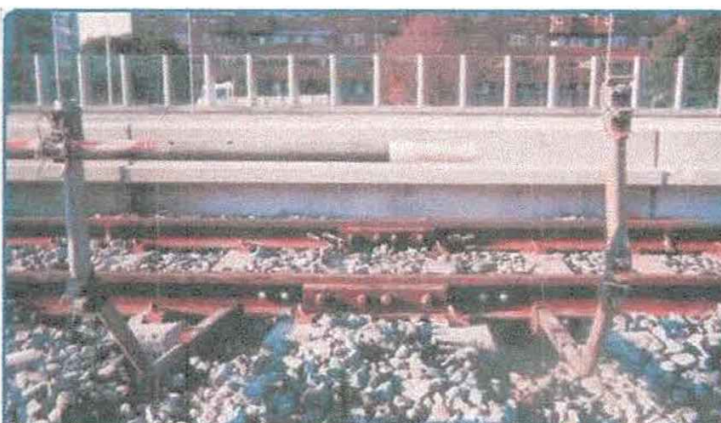
MANICOTTO ISOLANTE TRA DUE ELEMENTI DEL CORRENTE GRIZZ.
