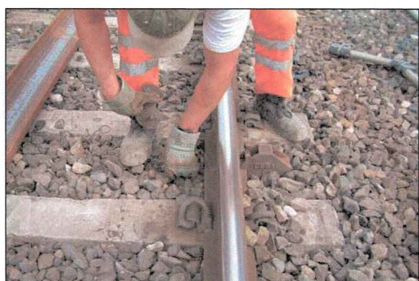
FOTO 06 Montaggio scarpa di ancoraggio al binario
