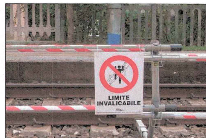
FOTO 04 Parapetto di protezione del cantiere e segnaletica di divieto
