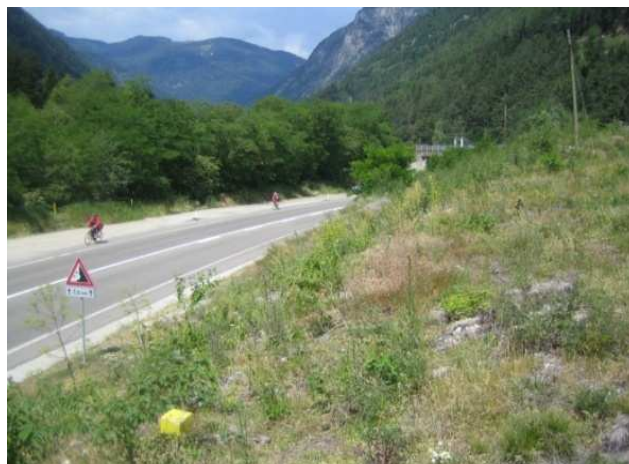
Abb.26 Deutlicher, visueller Unterschied des Hangs oberhalb der Staatsstraße (Quadrant 1A) Fig.26 Netta differenza visiva del versante a monte ed a valle della strada statale (quadrante 1A)
