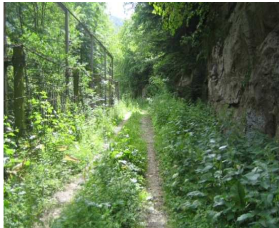
Abb. 5 Elastischer Steinschlagschutz längs der Eisenbahn – südöstlicher Bereich (Quadrant 3D) Fig. 5 Barriera elastica lungo la ferrovia- zona sud orientale (quadrante 3D)
