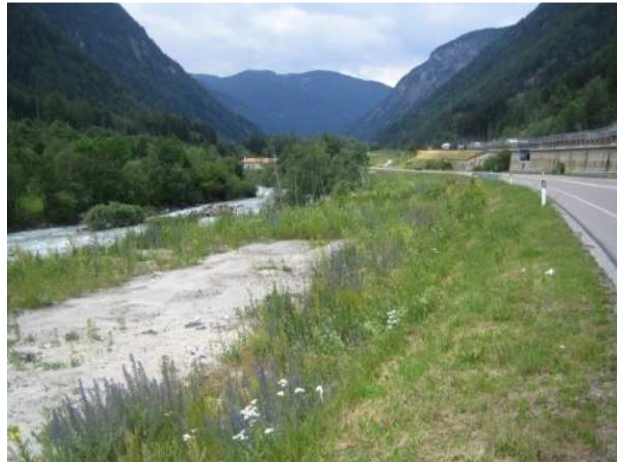
Abb 27 Anthropische Eingriffe südlich der Staatsstraße Fig 27 Interventi antropici sul lato sud della S.S. (quadrante 2D)
