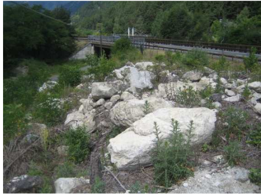
Abb. 3 Felsbrocken an der Böschung oberhalb der Staatsstraße (Quadrant 1A)
