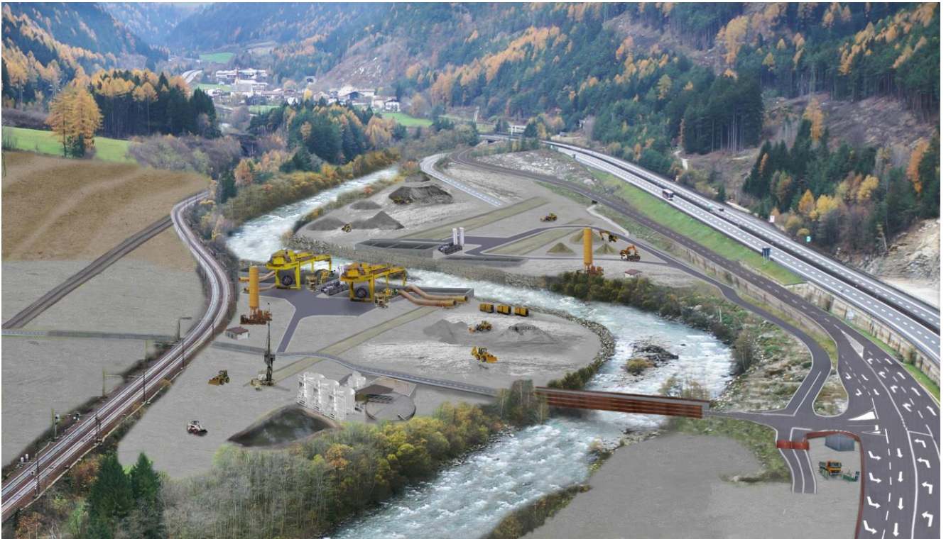
Foto des Baustellengebiets — Ausführungsprojekt
