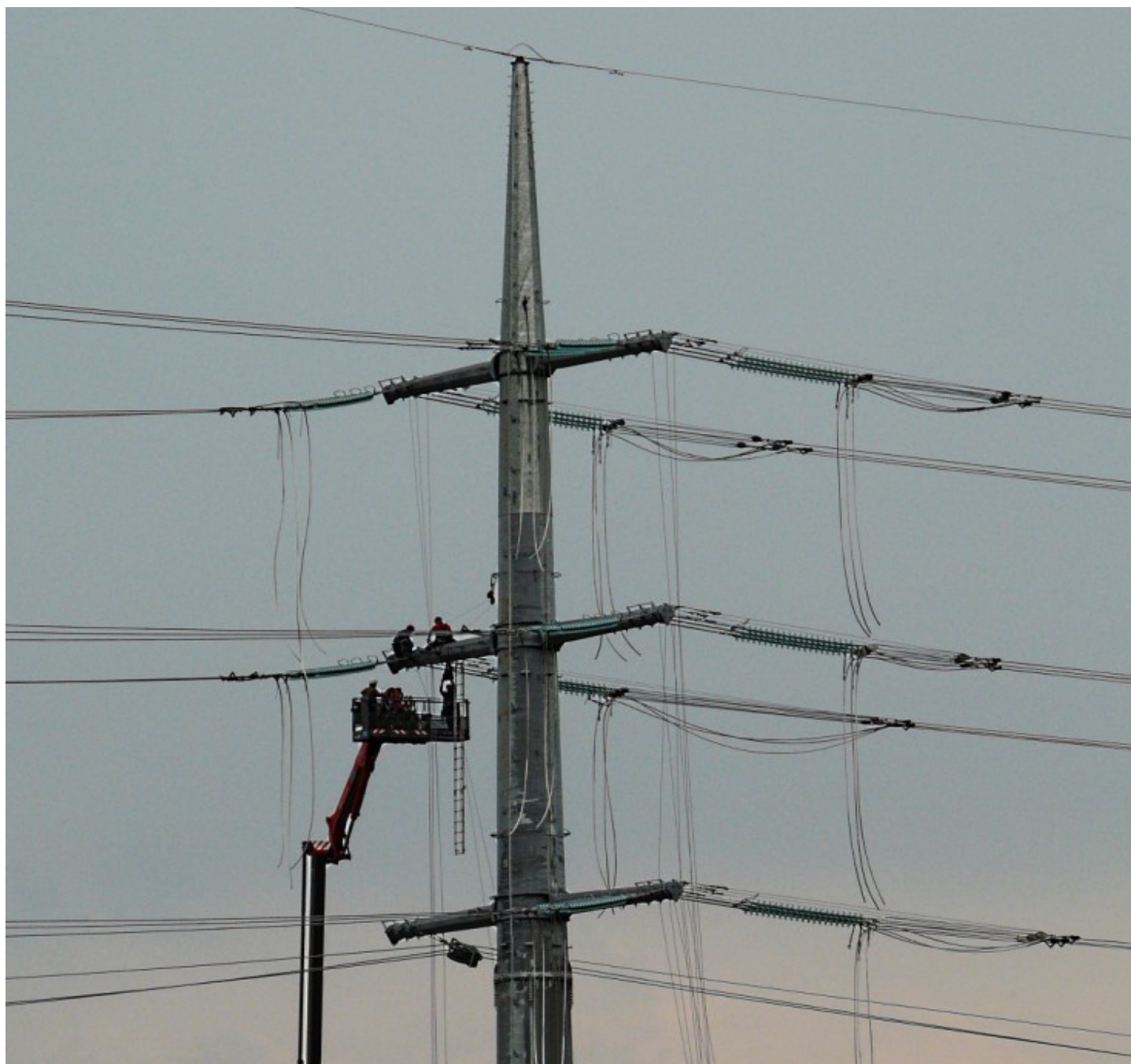
Foto 1 sostegno n. 34 con l'area di cantiere lungo la SR 353 Pozzuolo-Mortegliano il 24 e 25/07/15 (armamento sostegno)
