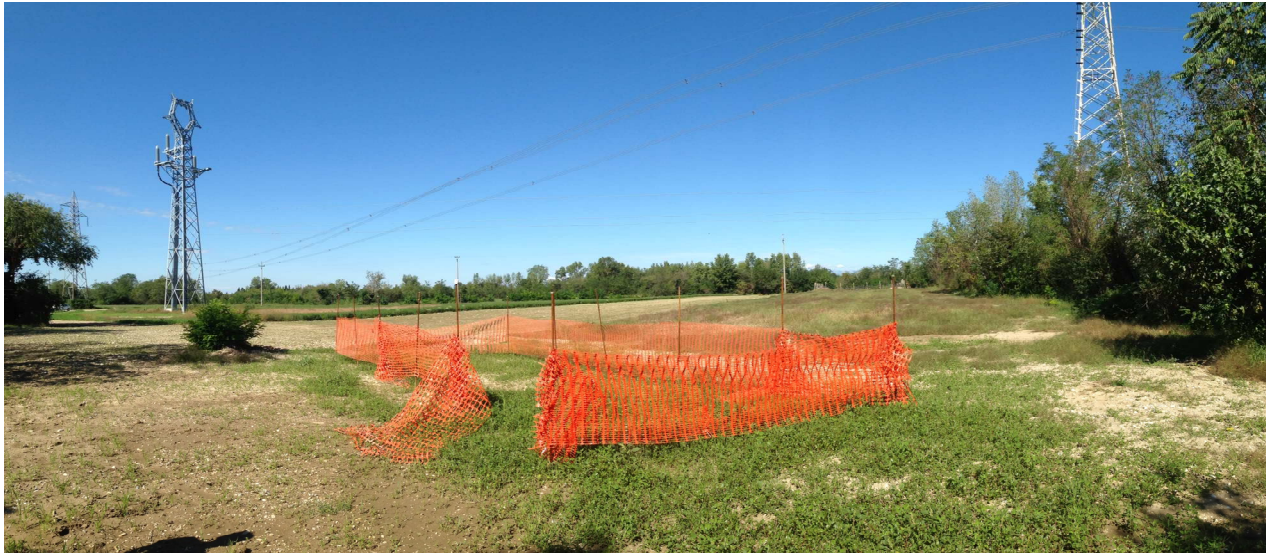
Foto Progressiva 85,69 m
