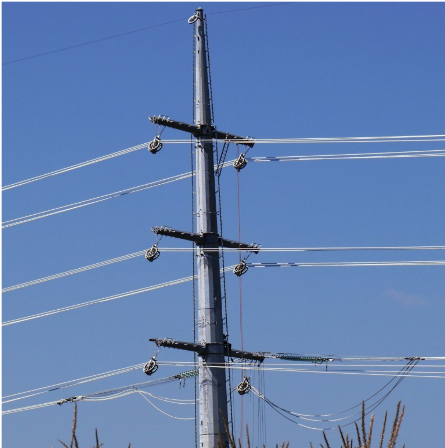
Foto 2 sostegno n. 43 sito lungo la strada Sammardenchia-Lavariano il 03/08/15
