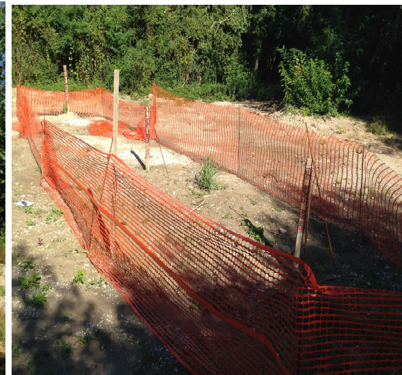
Foto Progressiva 939,11 m
