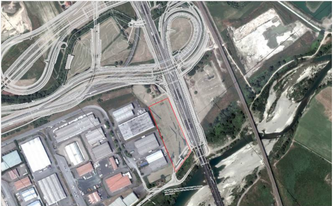
Foto 21 - Inquadramento dell'area di stoccaggio ASC5 su foto aerea. In rosso l'area interessata.
