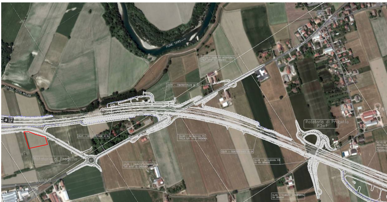
Foto 9 - Inquadramento dell'area di cantiere 2B su foto aerea. In rosso l'area interessata dal cantiere.
